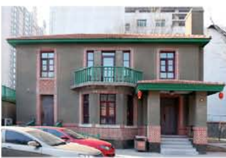
1. 东立面尺度、勒脚、门窗洞口及窗套样式
