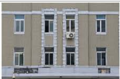
5. 立面混凝土预制隅石窗套
