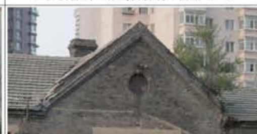
10. 南侧檐口线脚、砌筑样式及通风口
