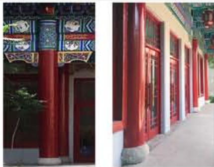
8. 南侧主入口柱子及壁柱的位置、样式、色彩
