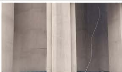
6.水塔混凝土柱式线脚形式
