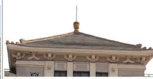
6. 建筑屋顶、屋脊装饰构件、檐口及檐下线脚1
