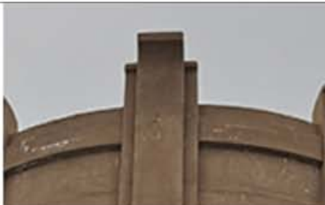
5.水塔壁柱顶部样式
