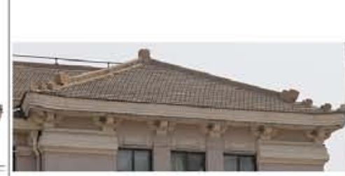
7. 建筑屋顶、屋脊装饰构件、檐口及檐下线脚2
