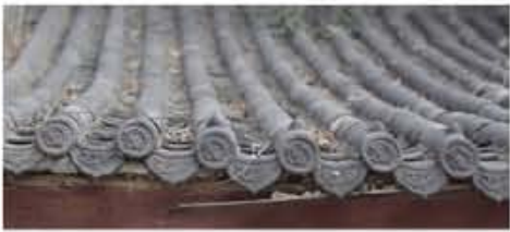
5.屋顶筒板瓦屋面样式
