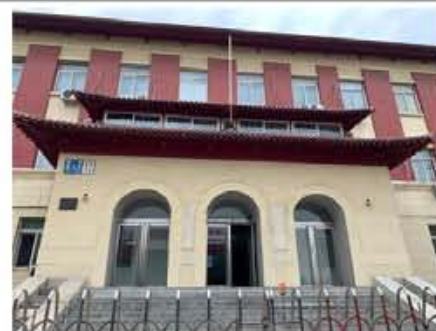
8. 东侧主入口重檐庑殿顶及拱券式门洞口样式
