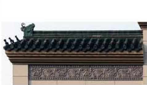
2. 南侧主入口绿琉璃瓦屋顶样式
