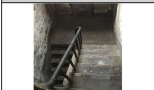
9. 室内双跑楼梯（混凝土梯段、金属扶手）
