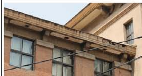
8. 建筑屋顶、屋脊装饰构件、檐口及檐下线脚3
