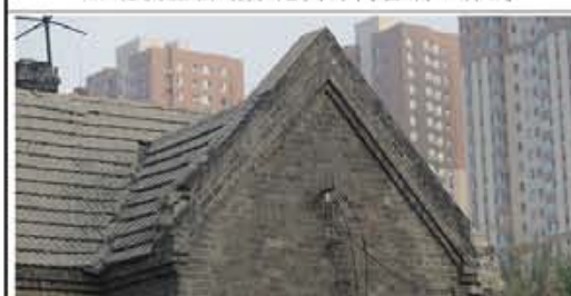
9. 西侧檐口线脚及砌筑样式
