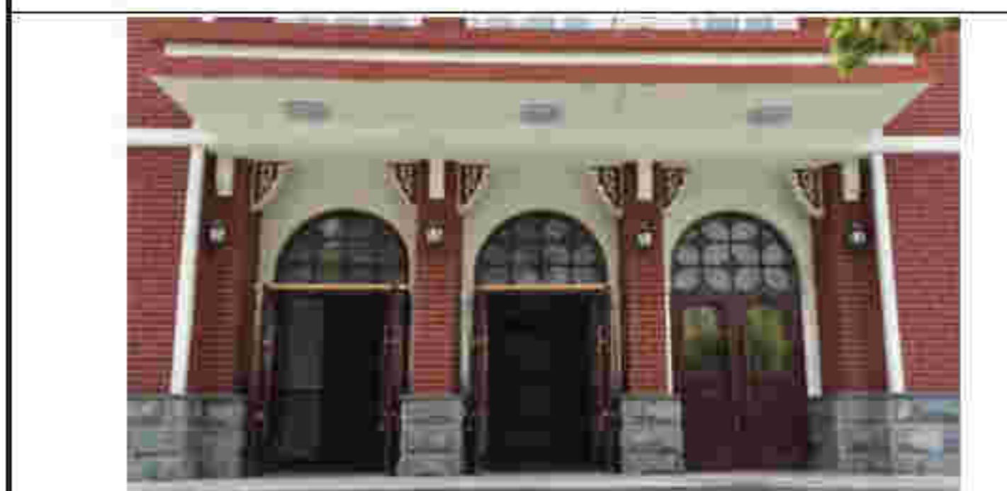
7. 建筑南立面主入口
