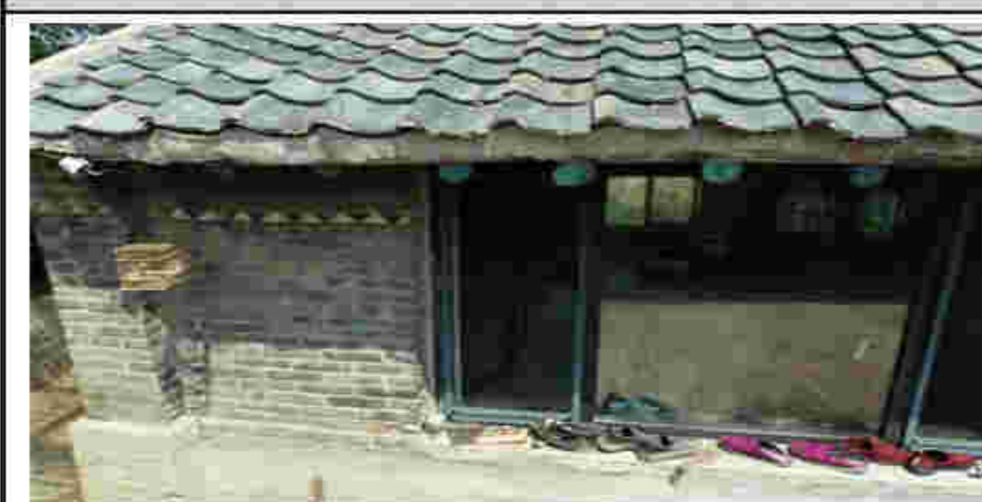
1. 建筑南立面及门窗洞口
