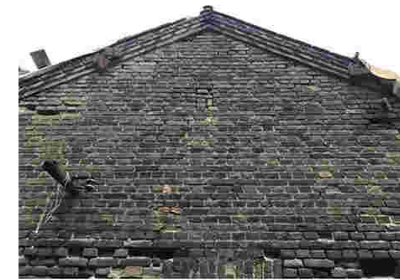
5. 立面青砖“一顺一丁”砌筑方式，山墙博缝样式
