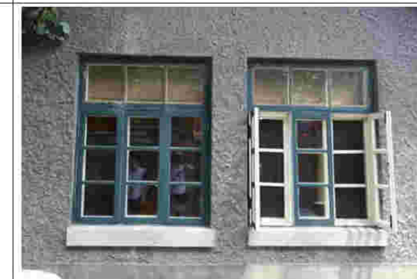
8. 建筑南立面窗洞口1
