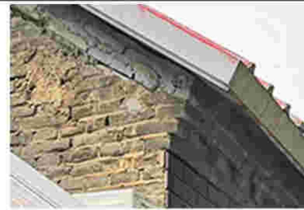
4. 东山墙墙面及砖檐砌筑
