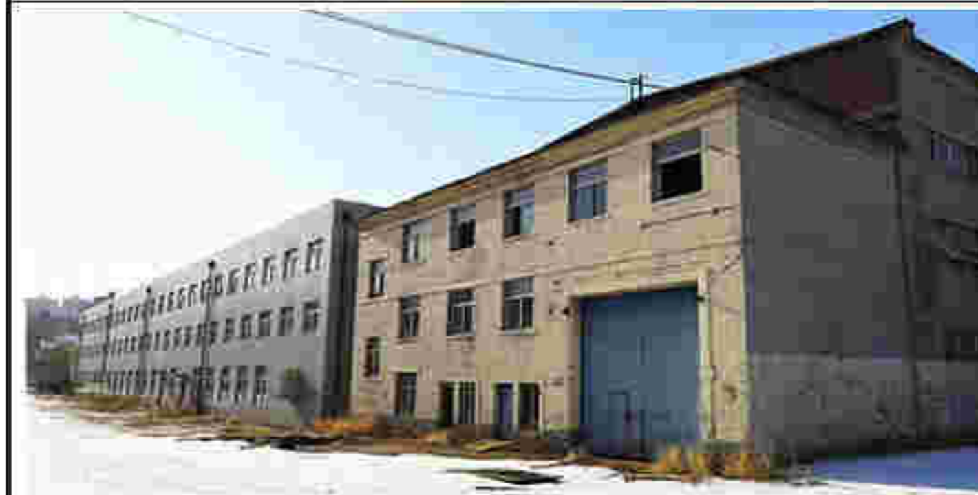
2. 建筑东立面及门窗洞口
