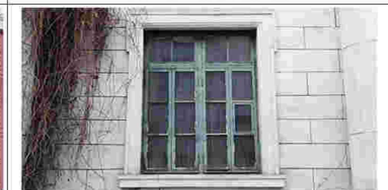
15. 南立面一层窗洞口
