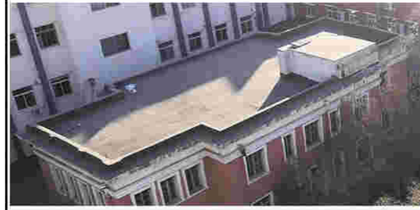
1. 建筑平屋顶及水平挑檐
