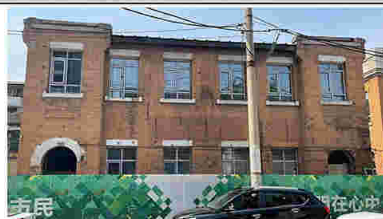
1. 东立面及门窗洞口
