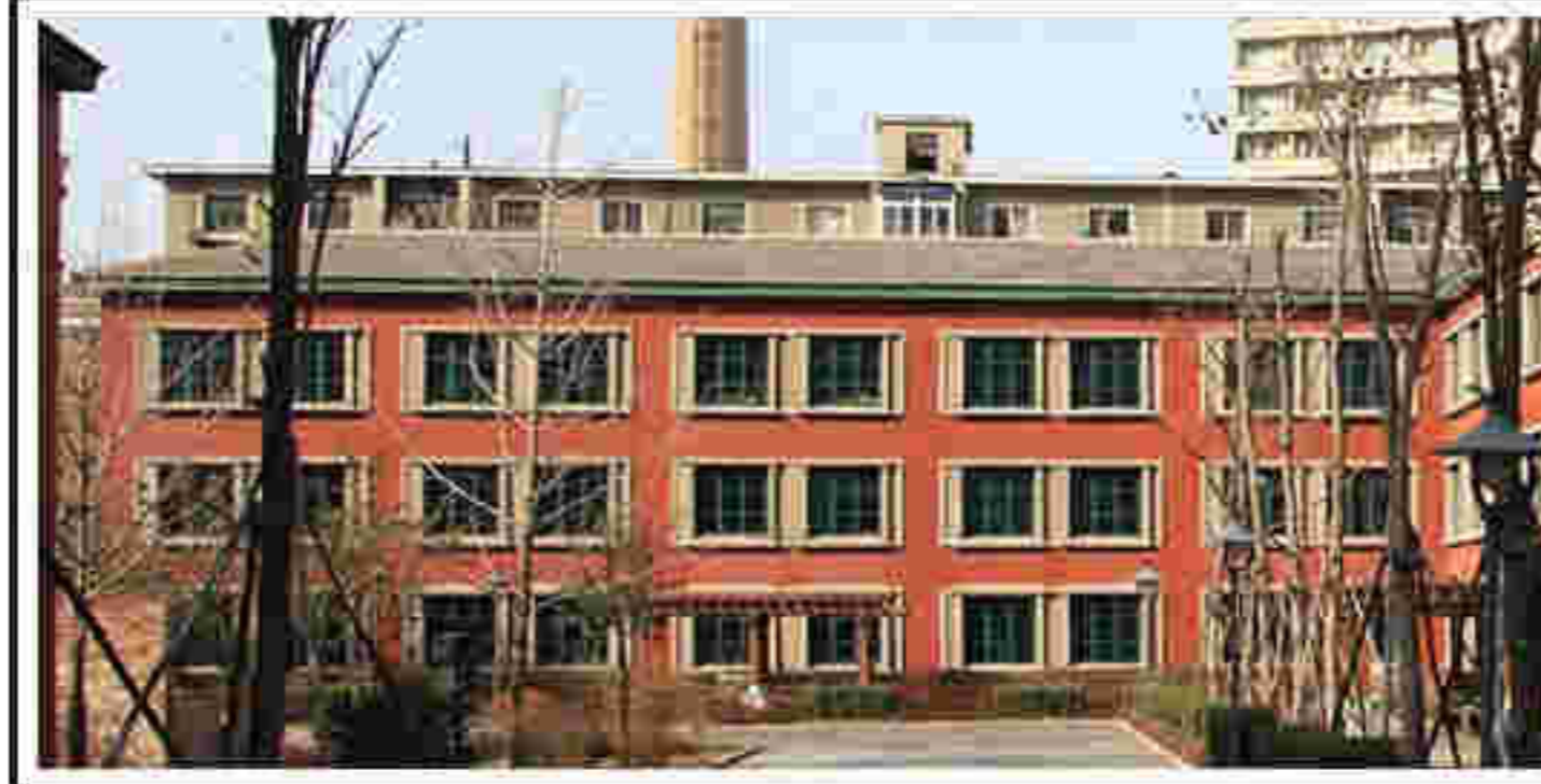
1. 东立面及门窗洞口
