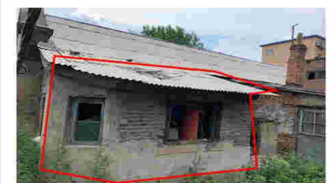
(4#) 北立面加建建筑
