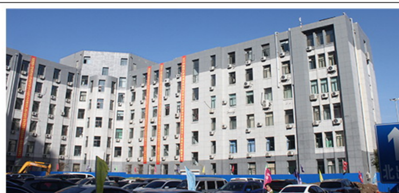
8. 建筑南立面及窗洞口
