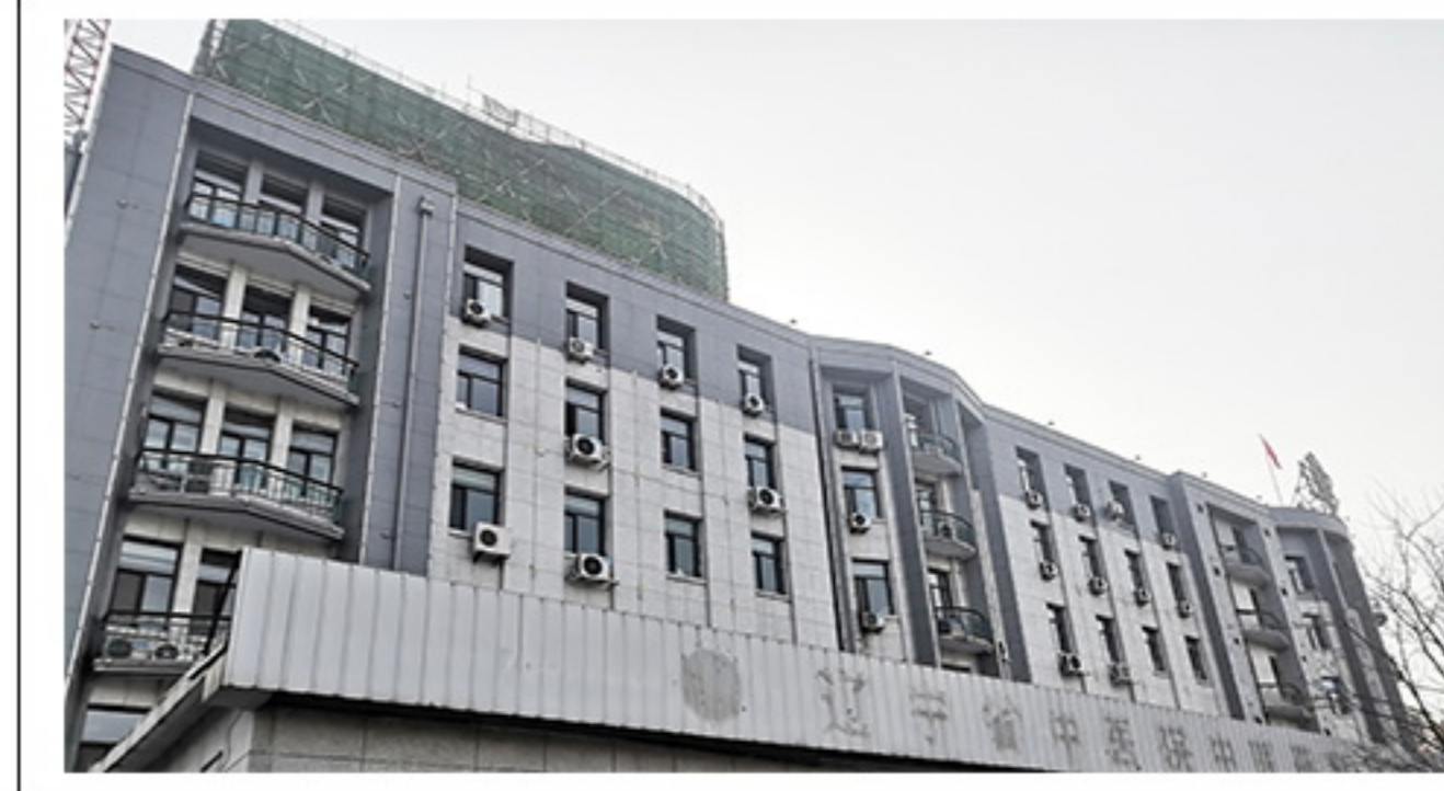
2. 建筑北立面及窗洞口
