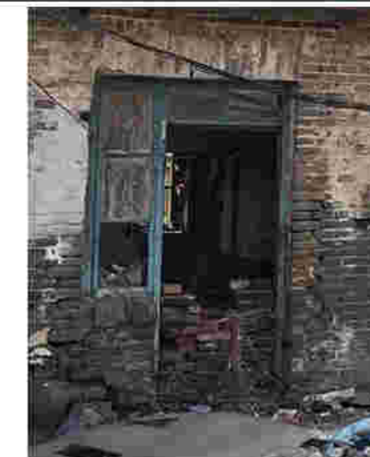
5. 建筑门窗洞口砌筑样式
