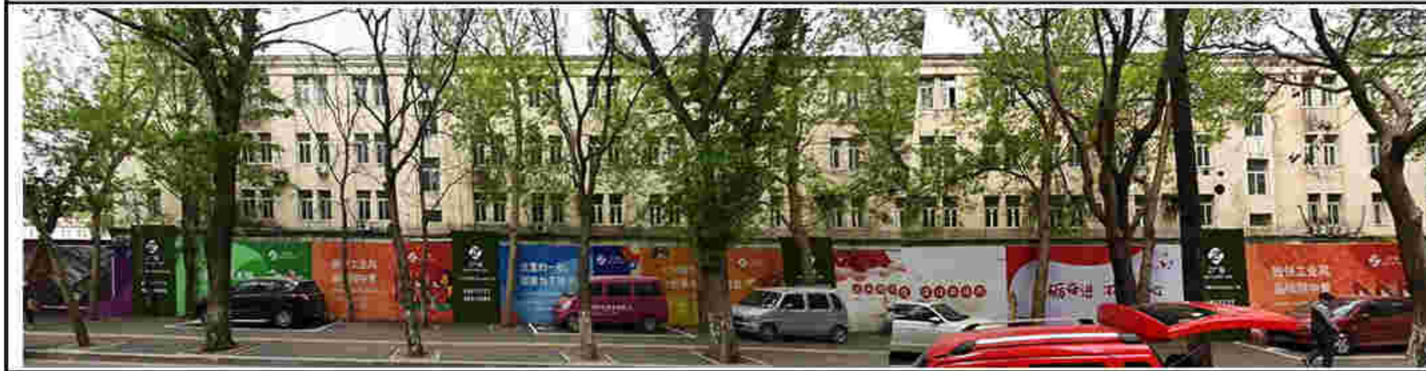
1. 建筑东立面及门窗洞口
