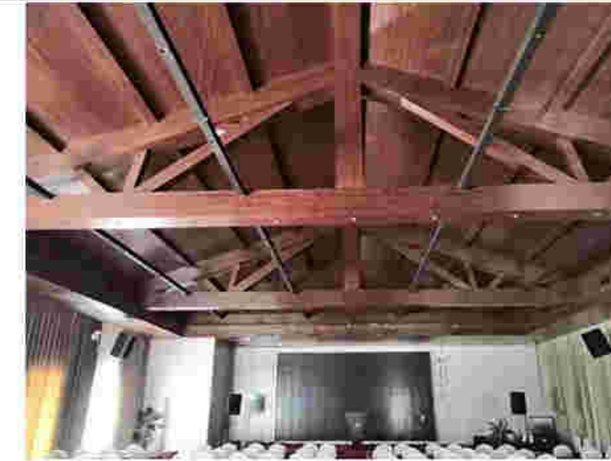
7. 建筑内部木结构屋架
