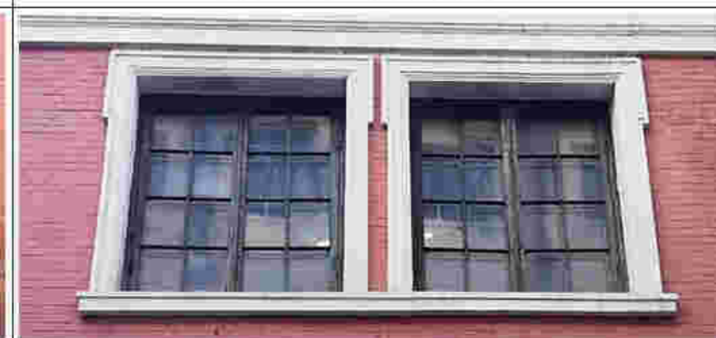
14. 南立面二层窗洞口
