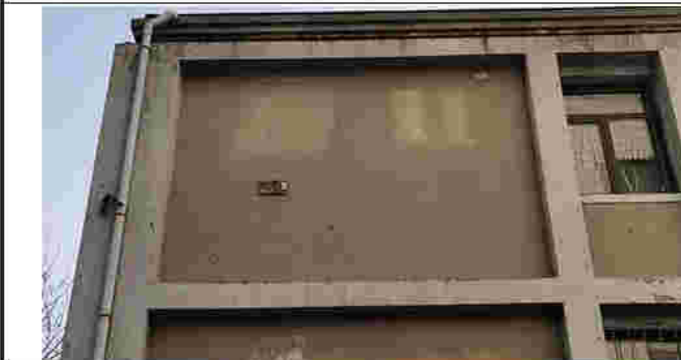
9. 北侧墙体垂直及水平装饰构件
