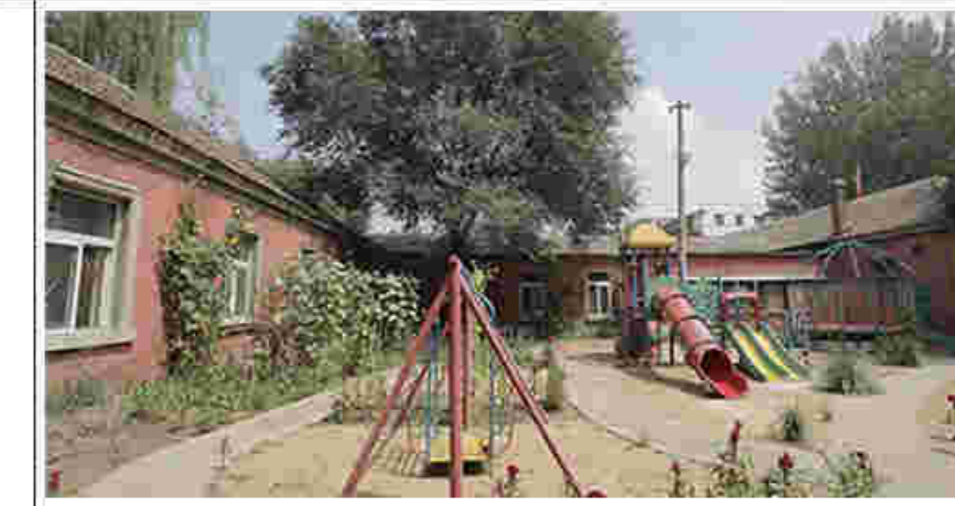
3. (02) 建筑西侧立面
