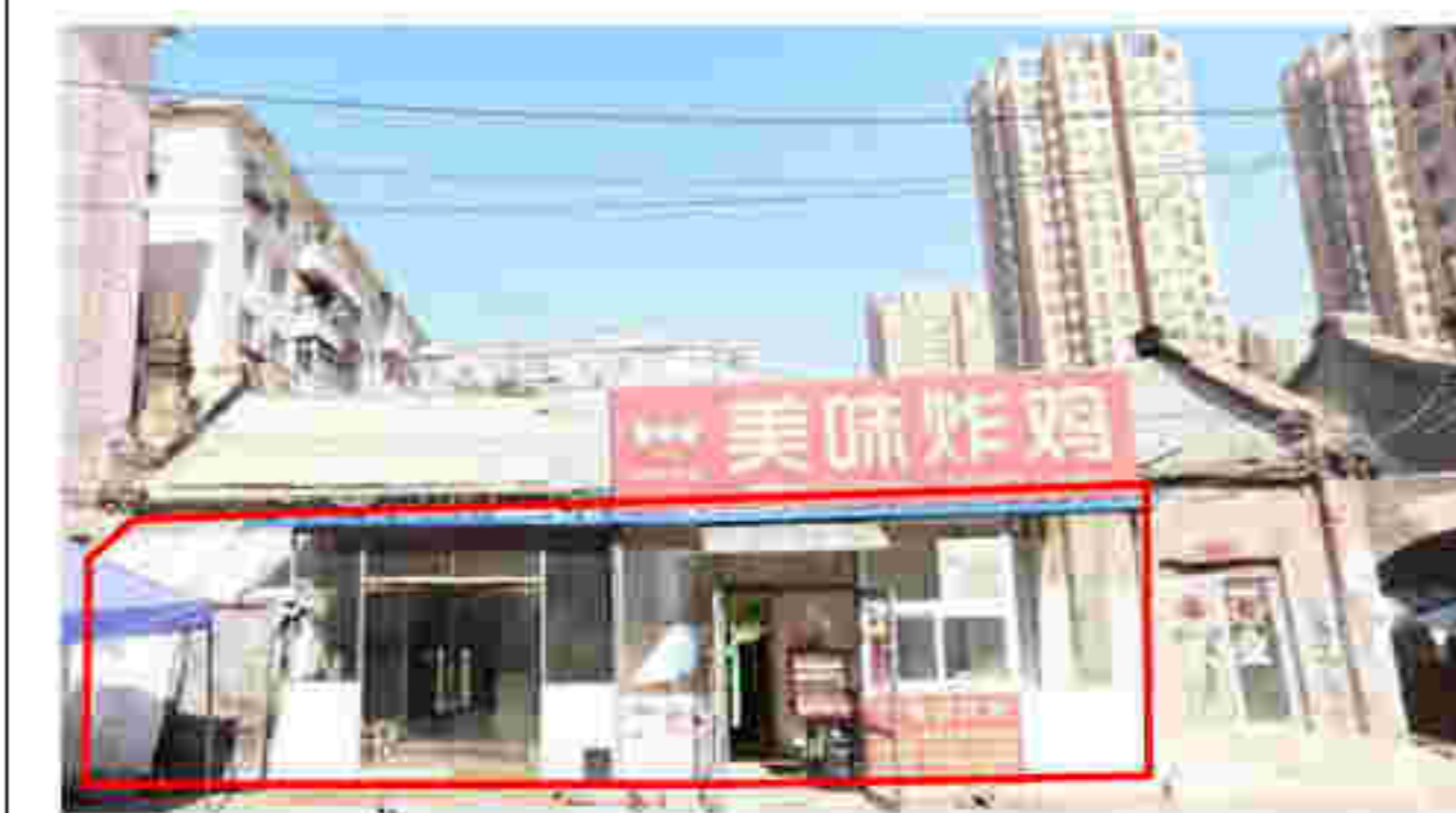
(1#) 南立面加建建筑
