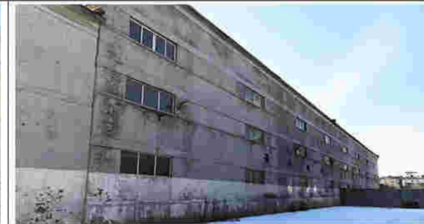
4. 建筑北立面及门窗洞口
