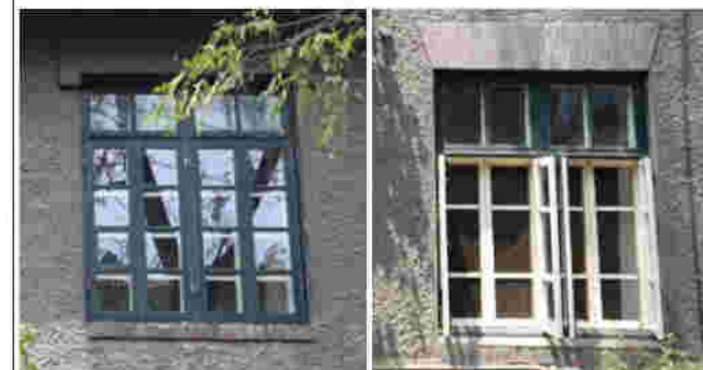
10. 建筑东立面窗洞口
