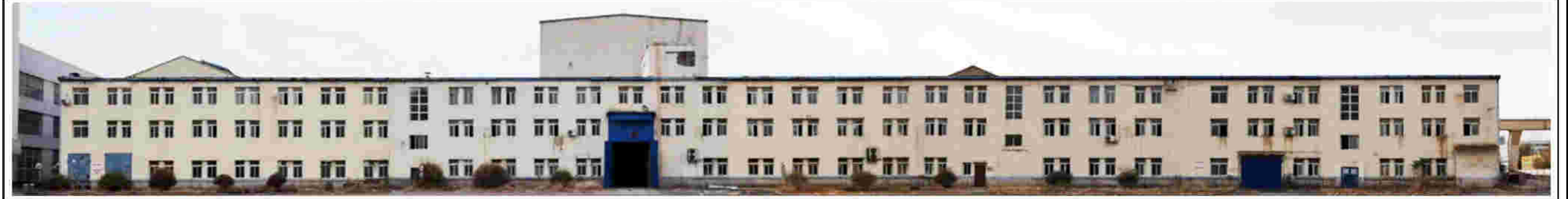
1. 建筑东立面及门窗洞口
