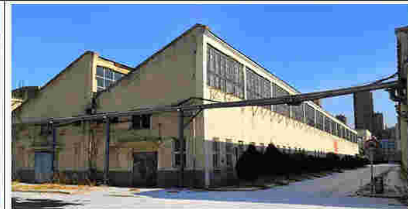
3. 建筑南立面及门窗洞口
