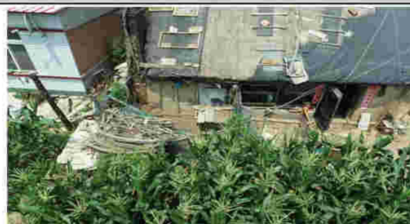
1. 建筑南立面及门窗洞口
