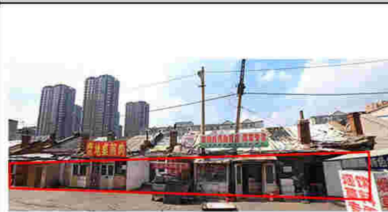
(8#建筑) 南立面加建建筑①
