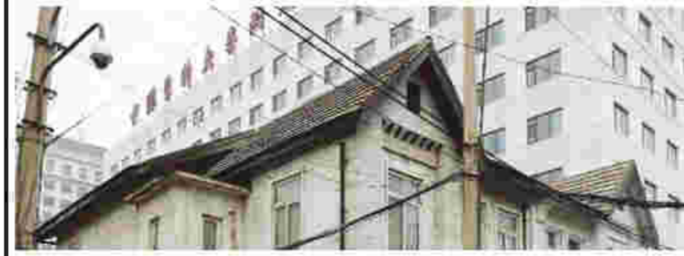
1. 建筑屋顶及檐口
