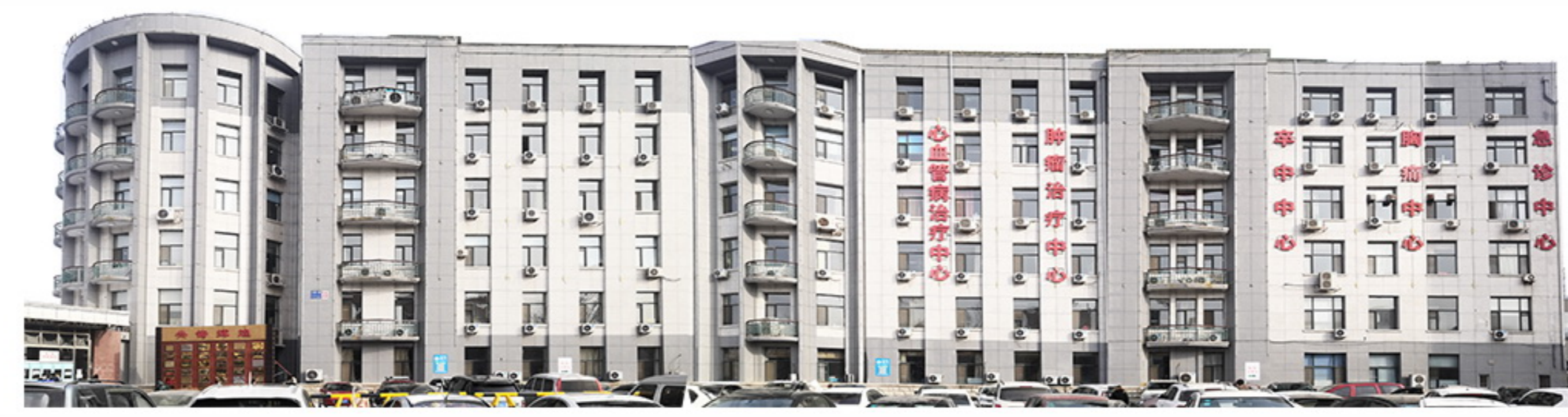
1. 建筑西立面及门窗洞口
