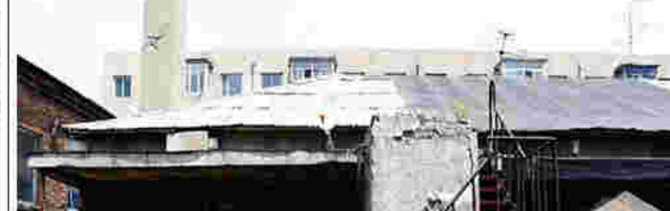
2. 北座建筑坡屋顶
