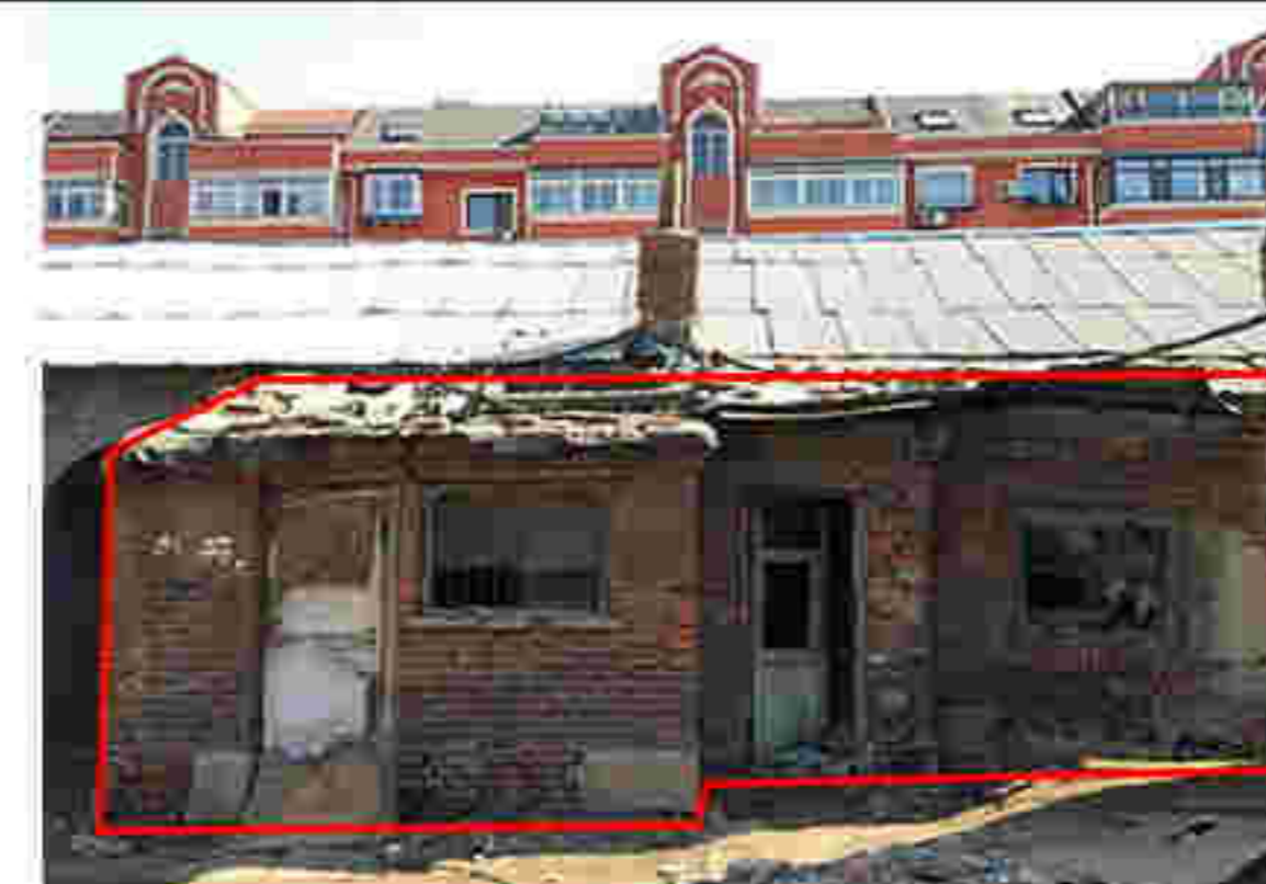
北立面加建建筑
