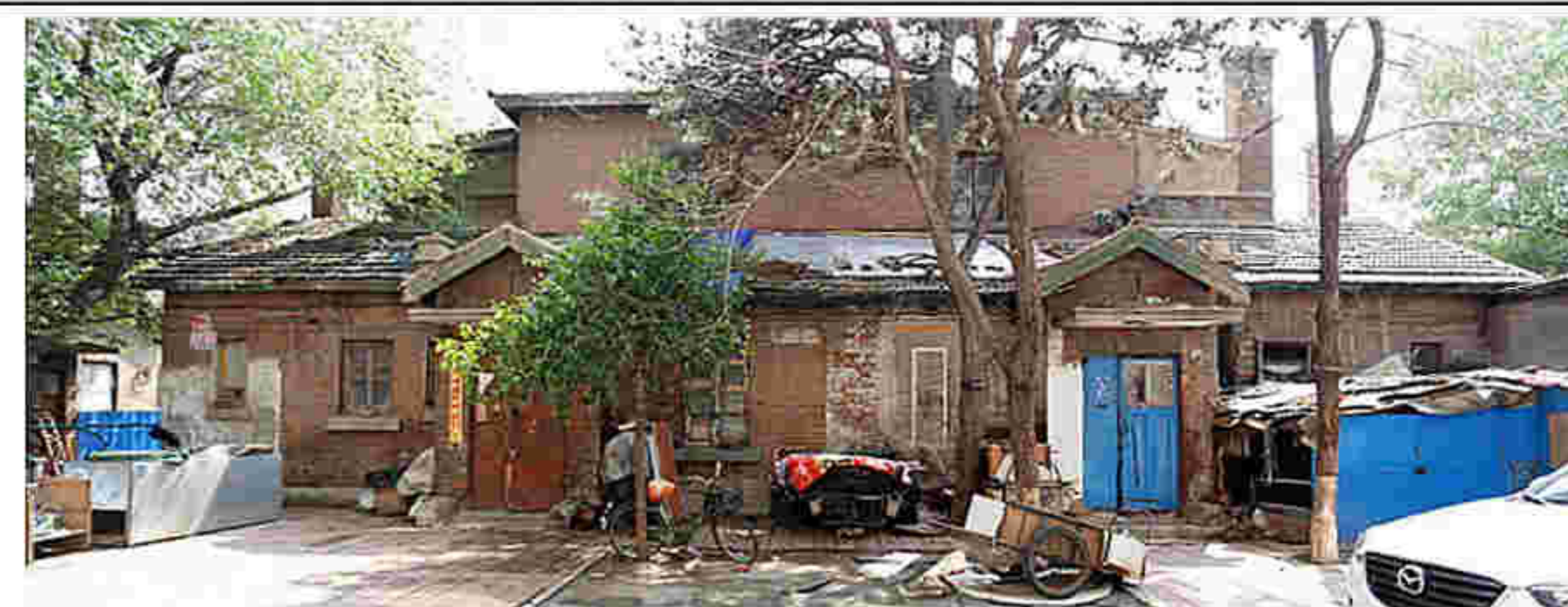
2. 北侧立面及门窗洞口
