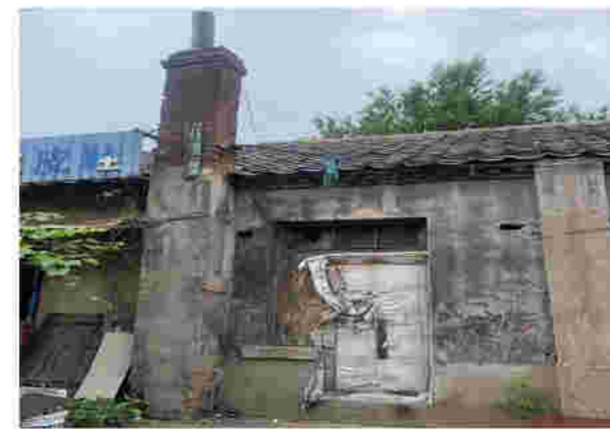
5. 落地式烟囱及外墙挂壁柱样式
