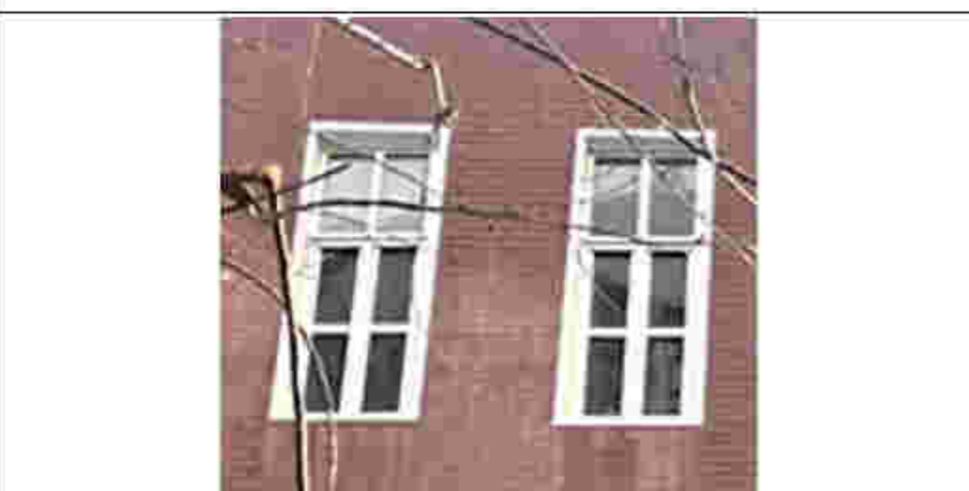
8. 建筑南立面窗洞口（一）
