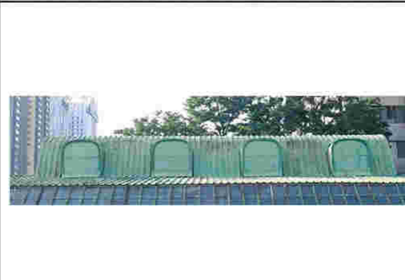
2. 建筑屋顶正脊圆筒
