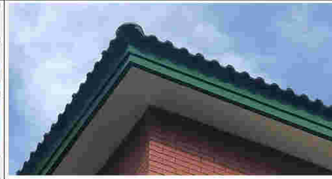
11. 建筑屋顶檐口
