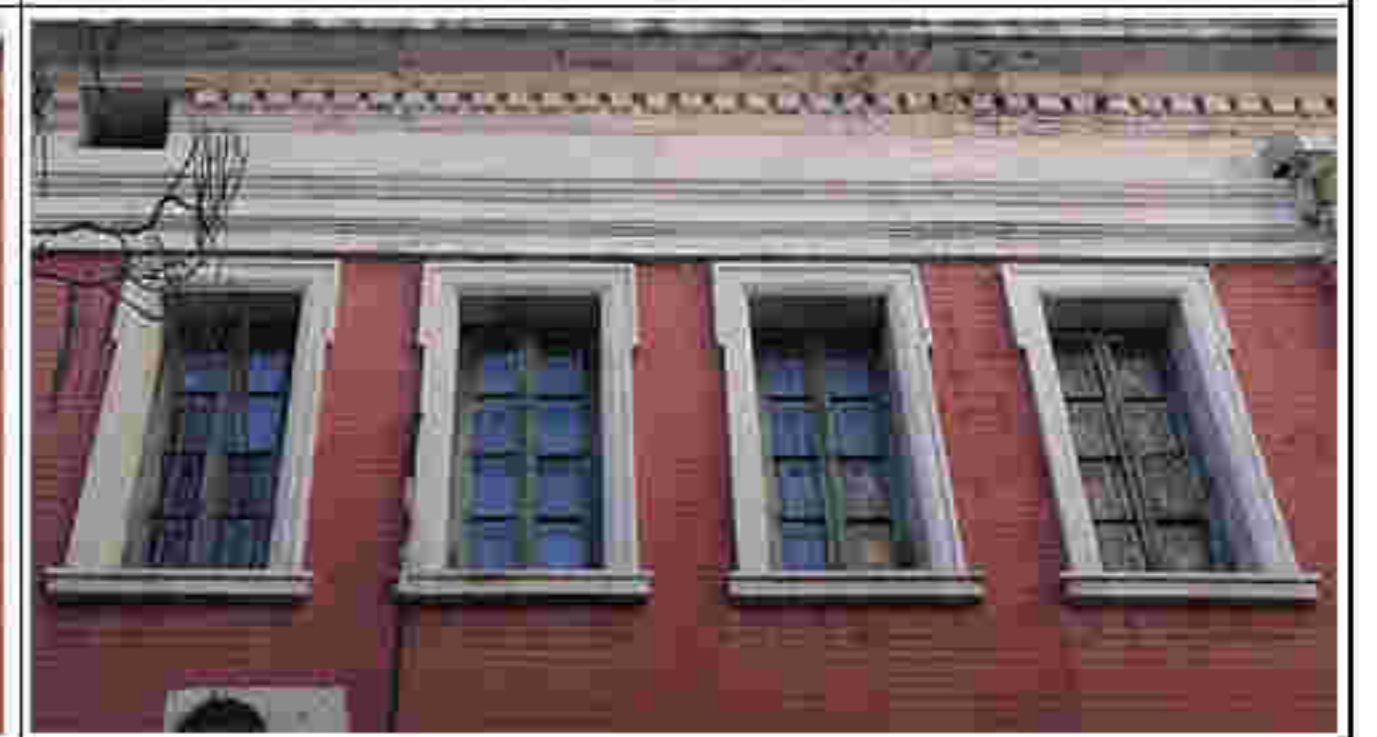
12. 东立面二层窗洞口
