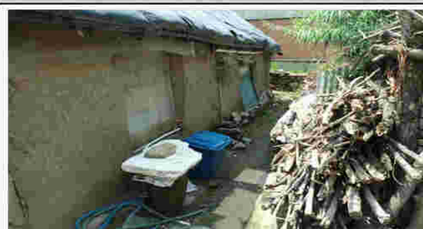
2. 建筑北立面及窗洞口
