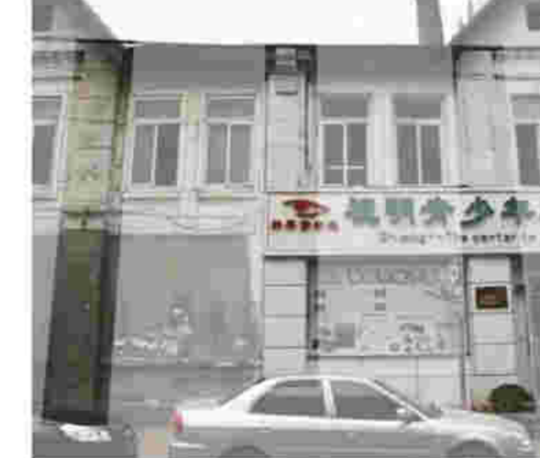
7. 广州街沿街立面壁柱
