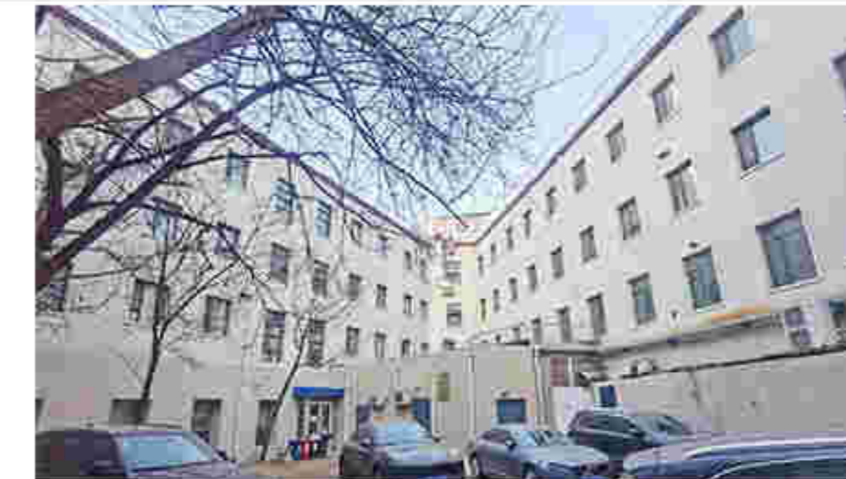
6. 西立面及窗洞口（内部）
