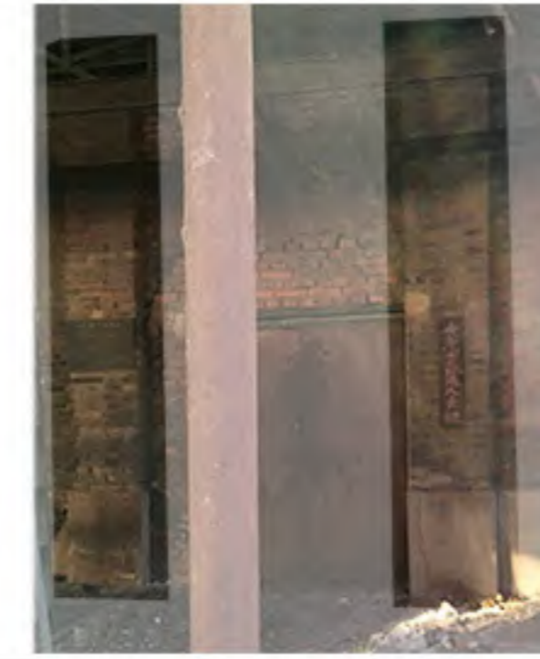
2. 建筑东立面壁柱
