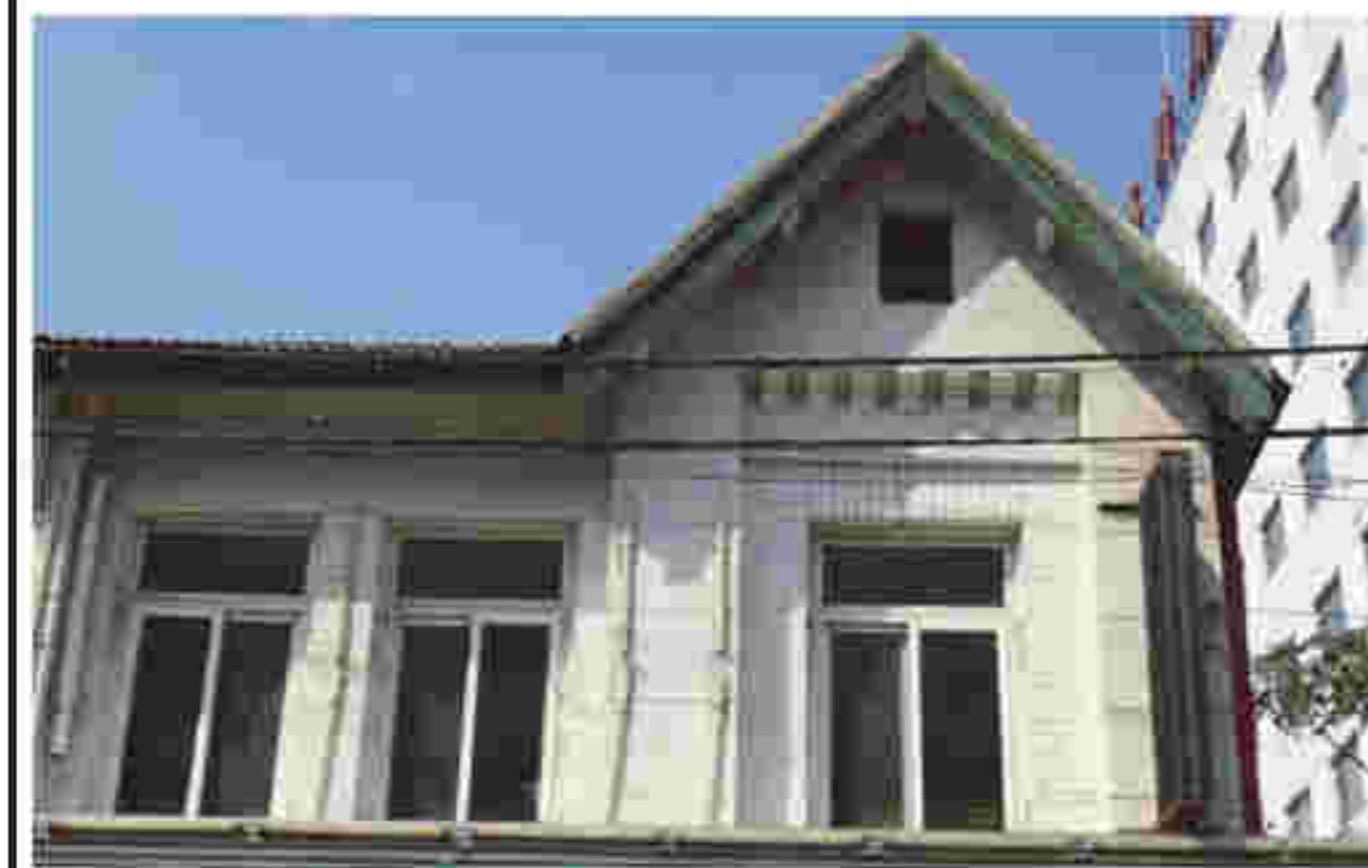
5. 广州街沿街立面屋顶檐口、窗洞口及装饰构件
