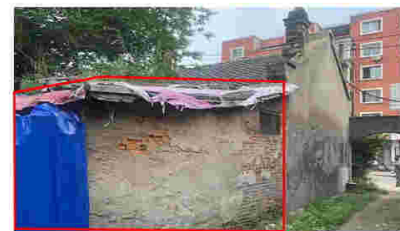
(2#) 北立面加建建筑
