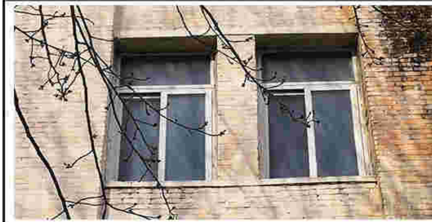
4. 建筑东立面窗洞口
