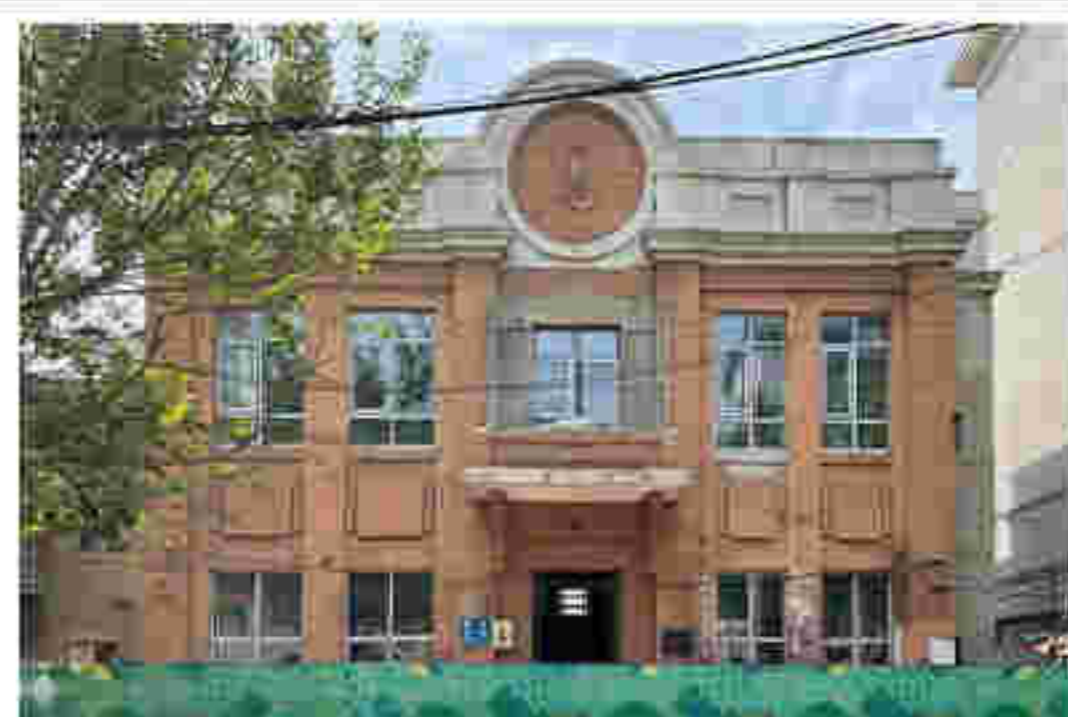
1. 东立面及门窗洞口
