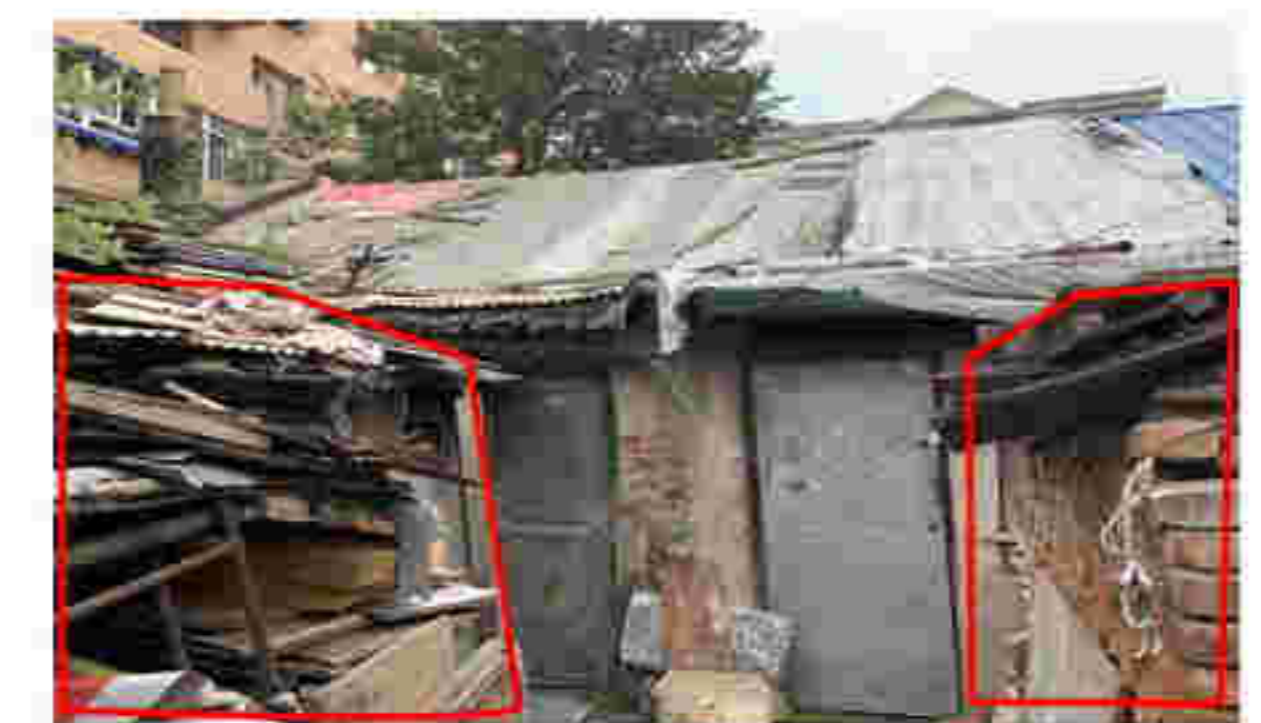
(3#) 北立面加建建筑
