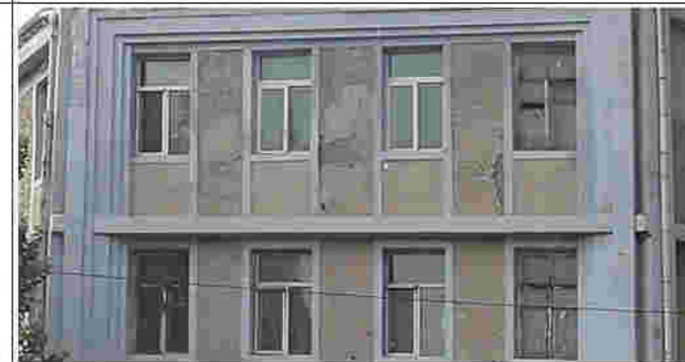
10. 东南侧立面窗洞及水平装饰
