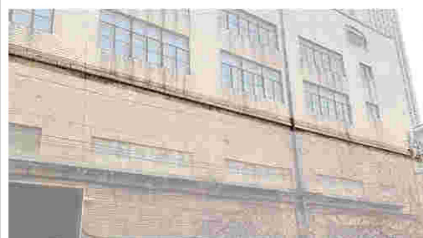
6. 建筑立面横向分隔线脚
