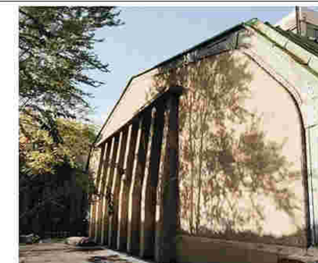
7. 建筑南立面壁柱
