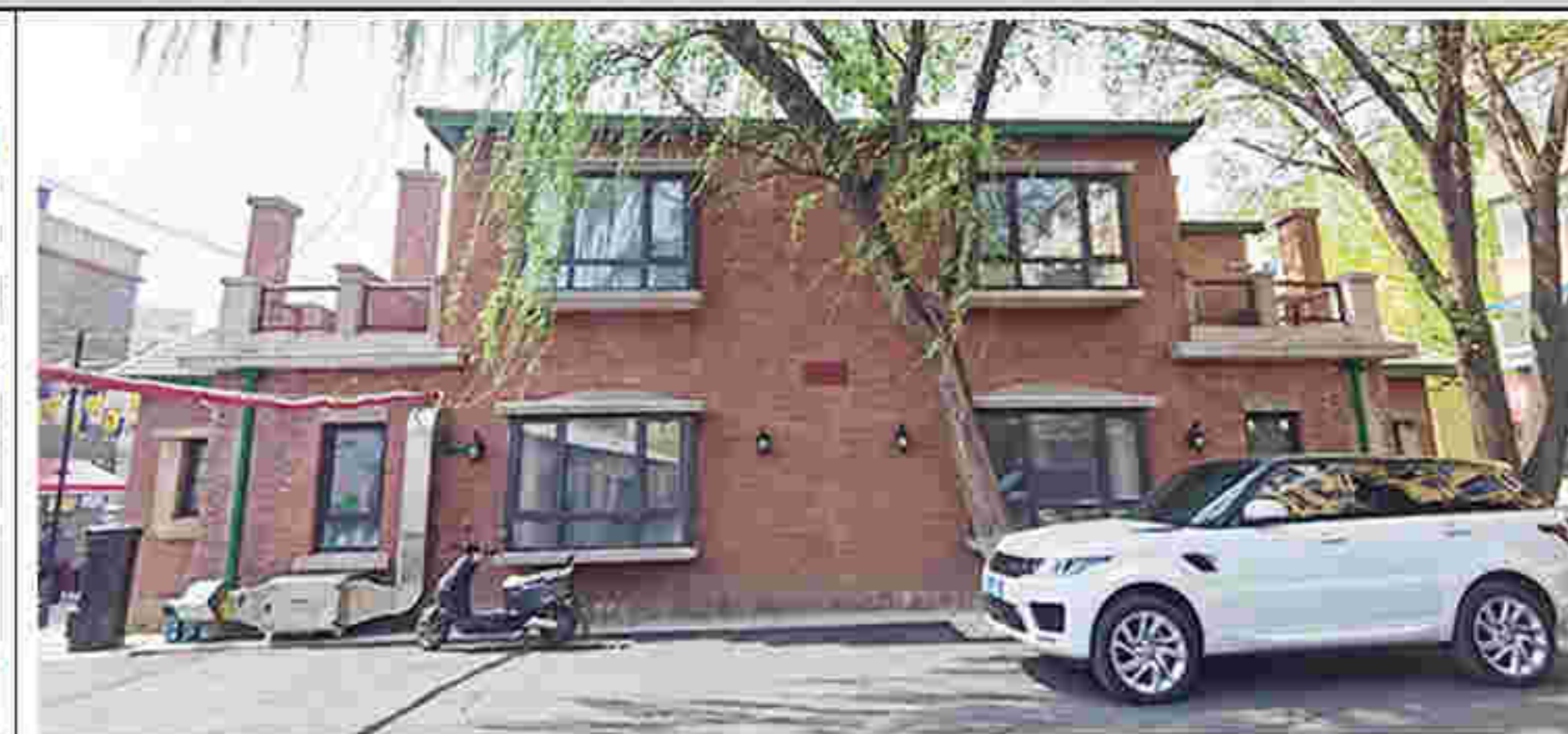
3. 东立面及门窗洞口
