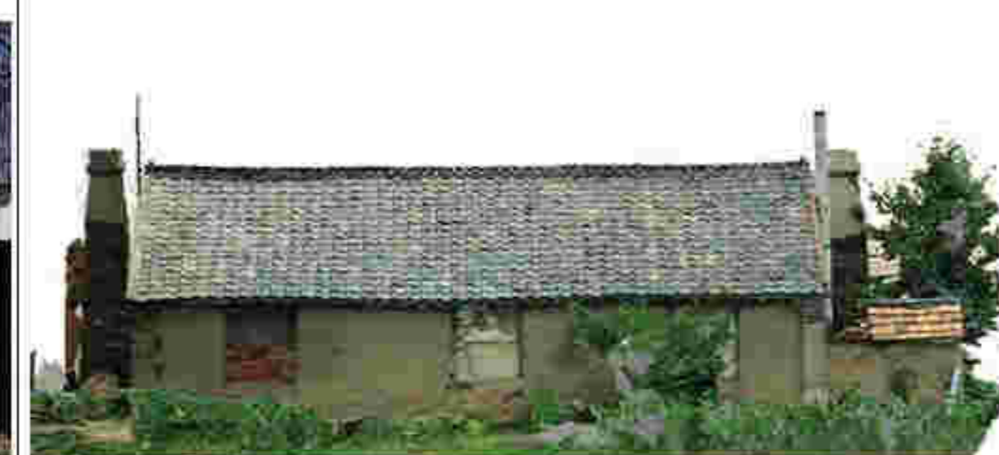
2. 建筑北立面及窗洞口
