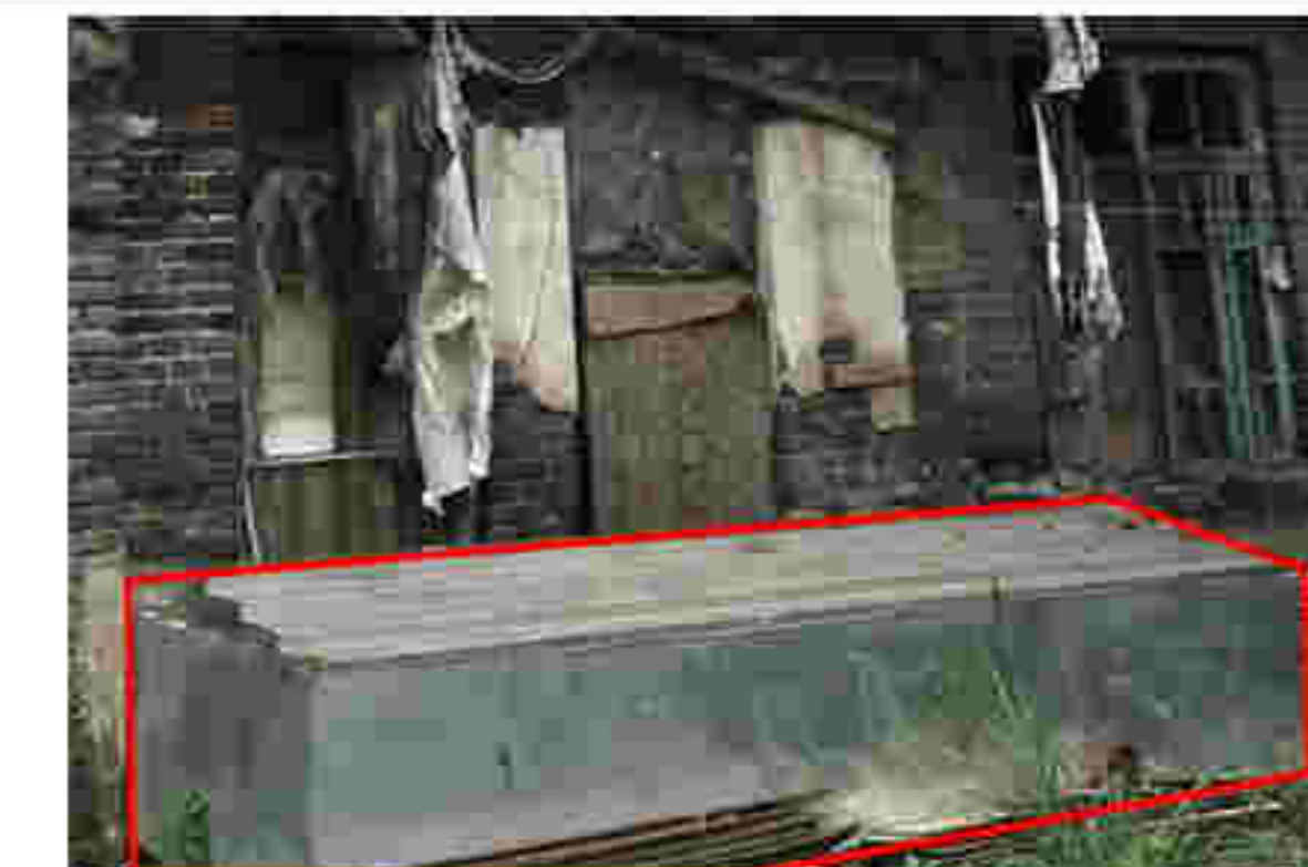
(13#建筑) 南立面加建建筑
