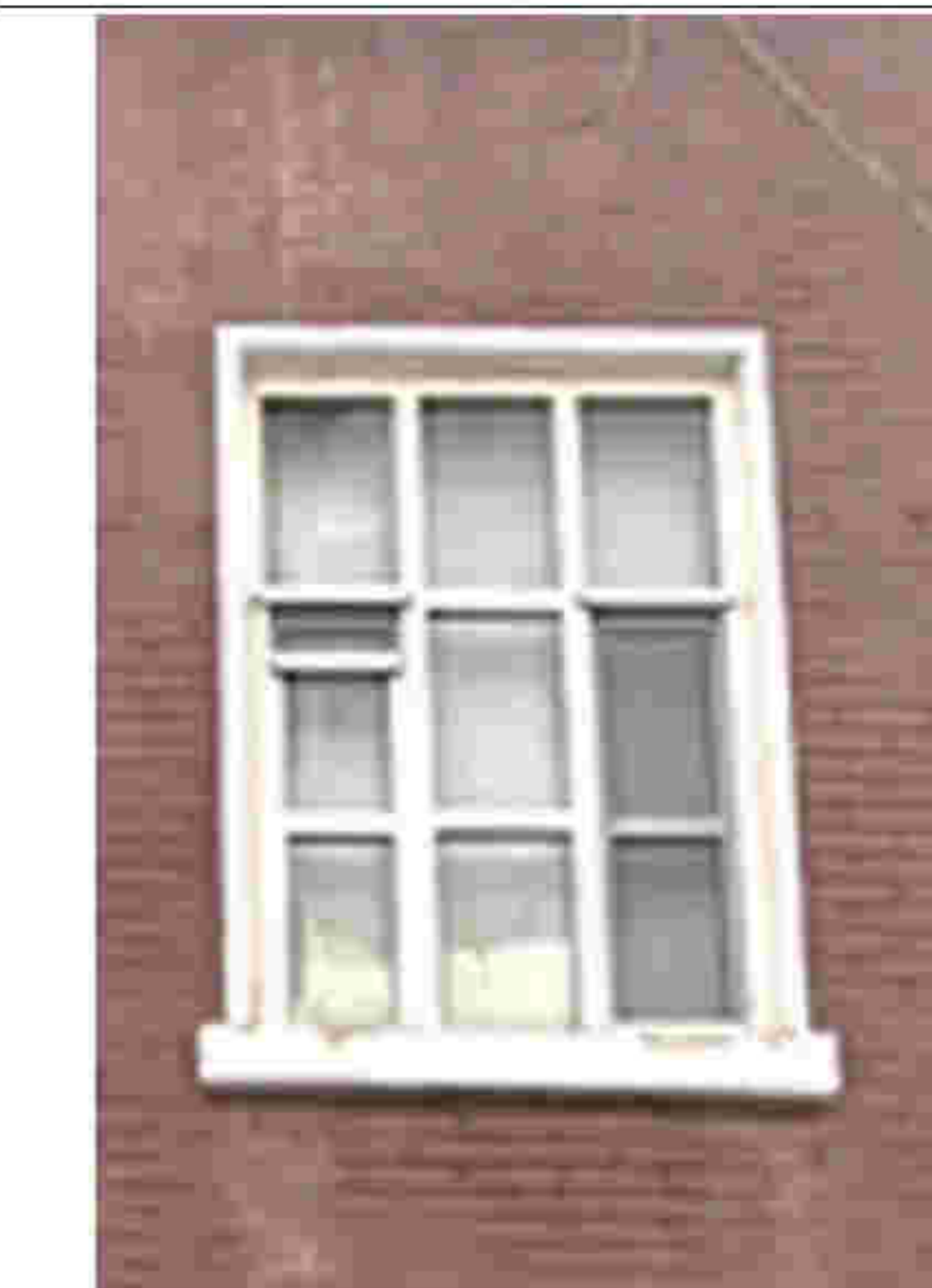
9. 建筑东立面窗洞口（二）
