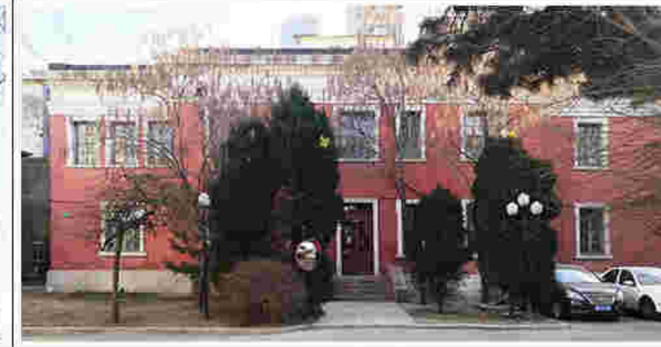
3. 建筑北立面及门窗洞口
