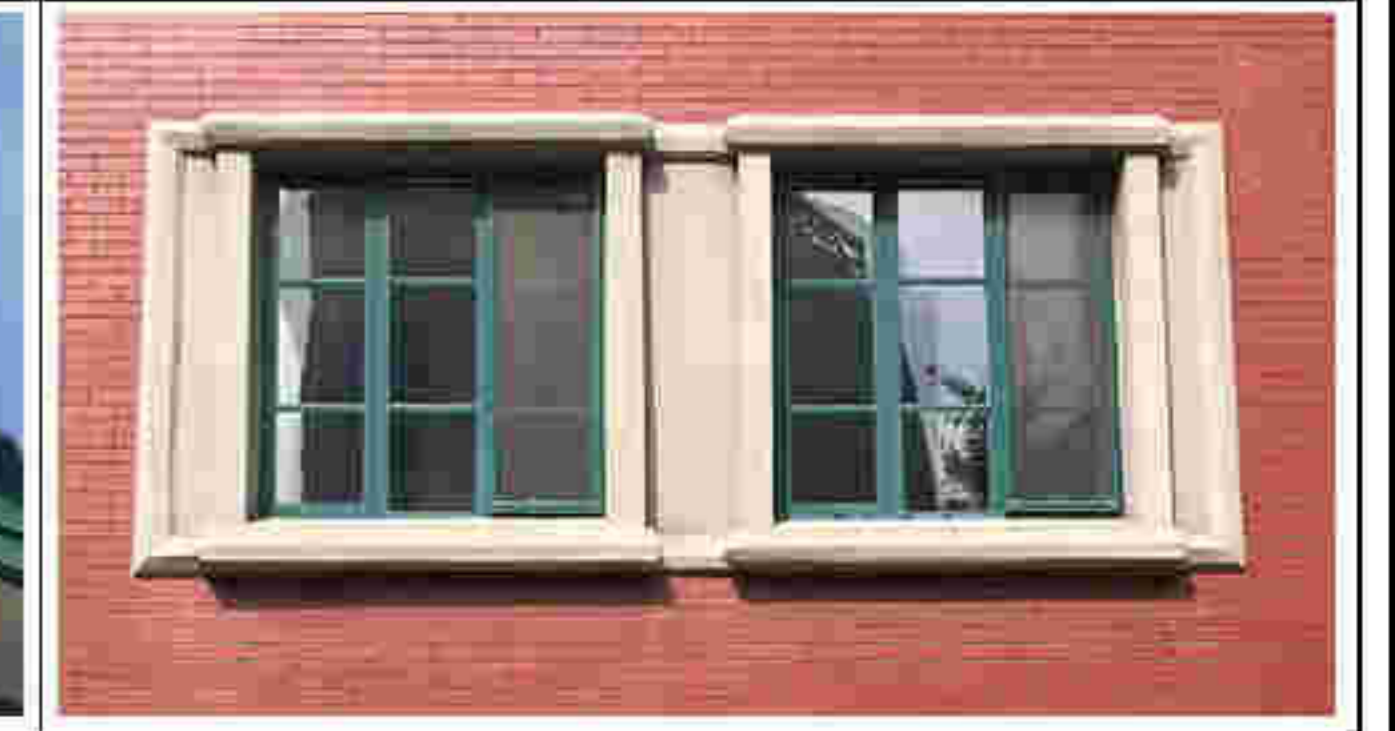
12. 东侧建筑窗洞口
