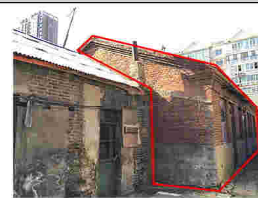
10. (10建筑) 南立面加建建筑
