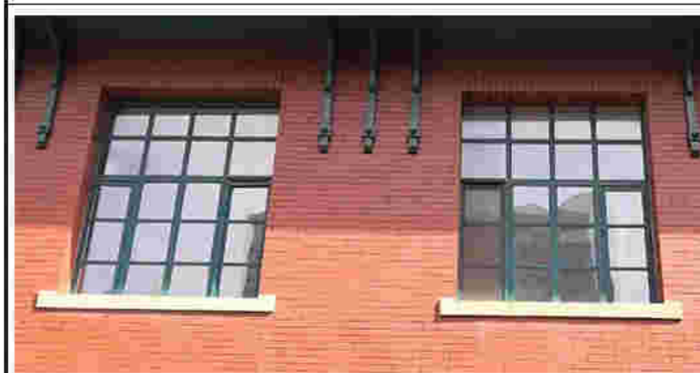
13. 南侧建筑窗洞口
