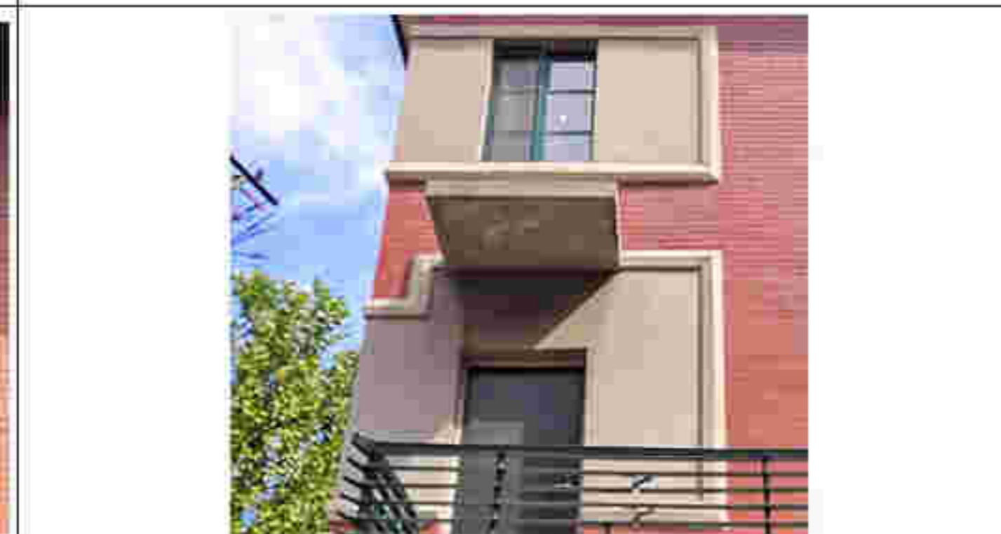
14. 建筑南侧立面装饰图案及雨棚
