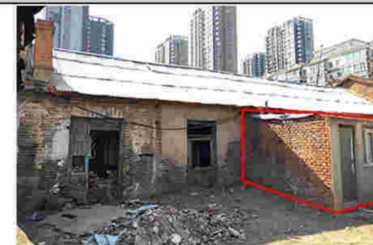
9. (10建筑) 东立面加建建筑①
