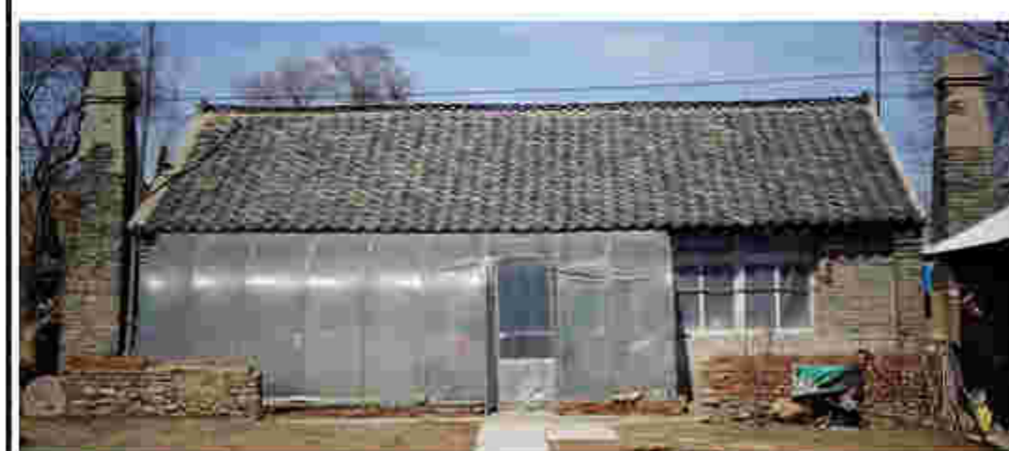
1. 建筑南立面及门窗洞口
