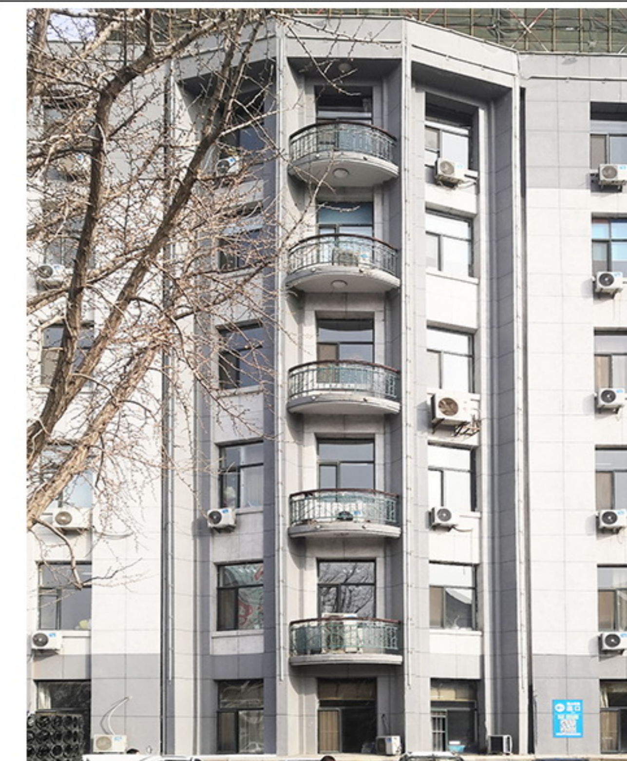
5. 建筑立面片段（一）
