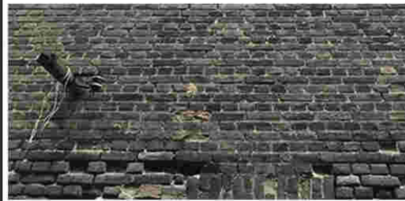
4. 立面青砖“一顺一丁”砌筑方式, 山墙博缝样式
