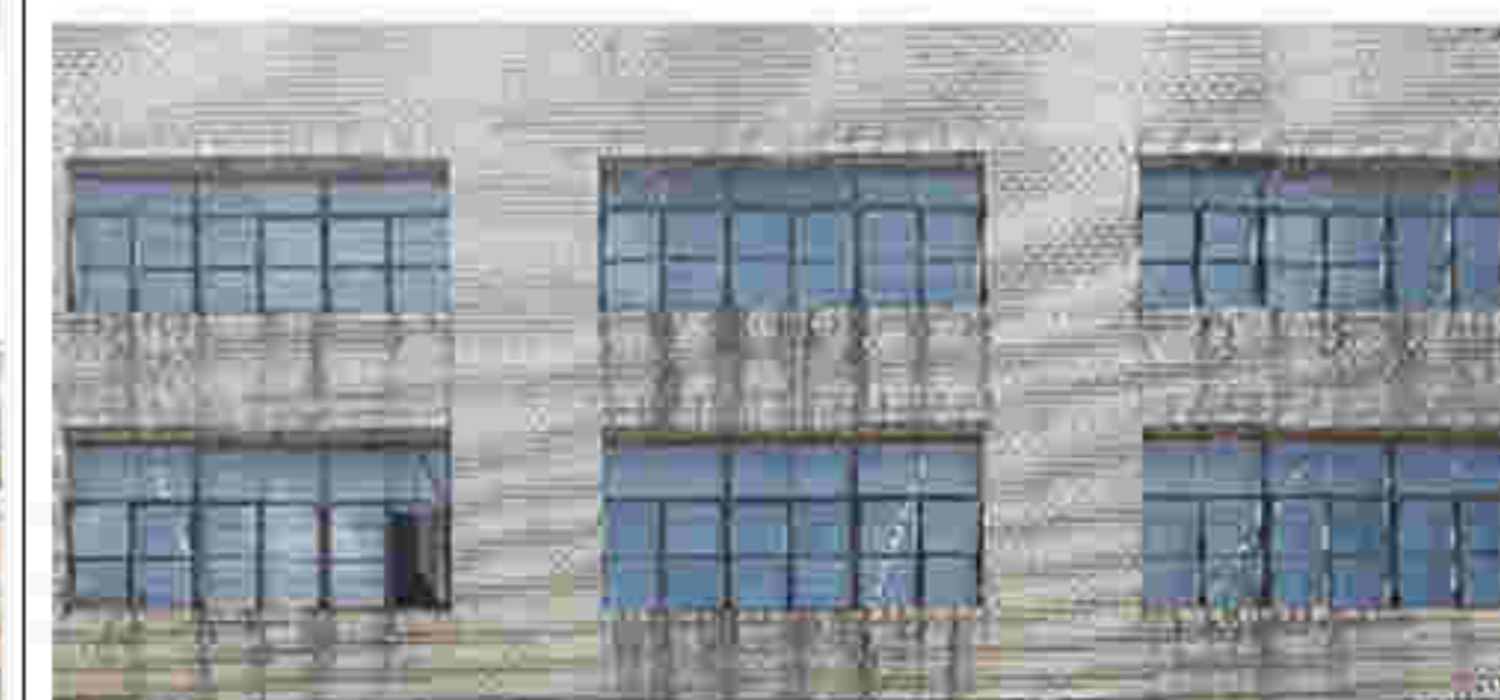
7. 北三马路沿街立面窗洞口1
