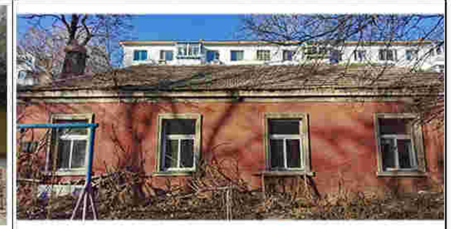
4. (02) 建筑南侧立面
