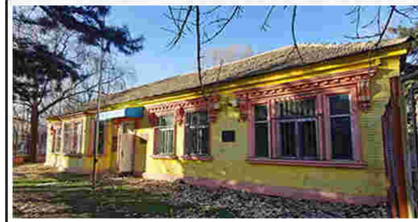
1. (01) 建筑南侧立面
