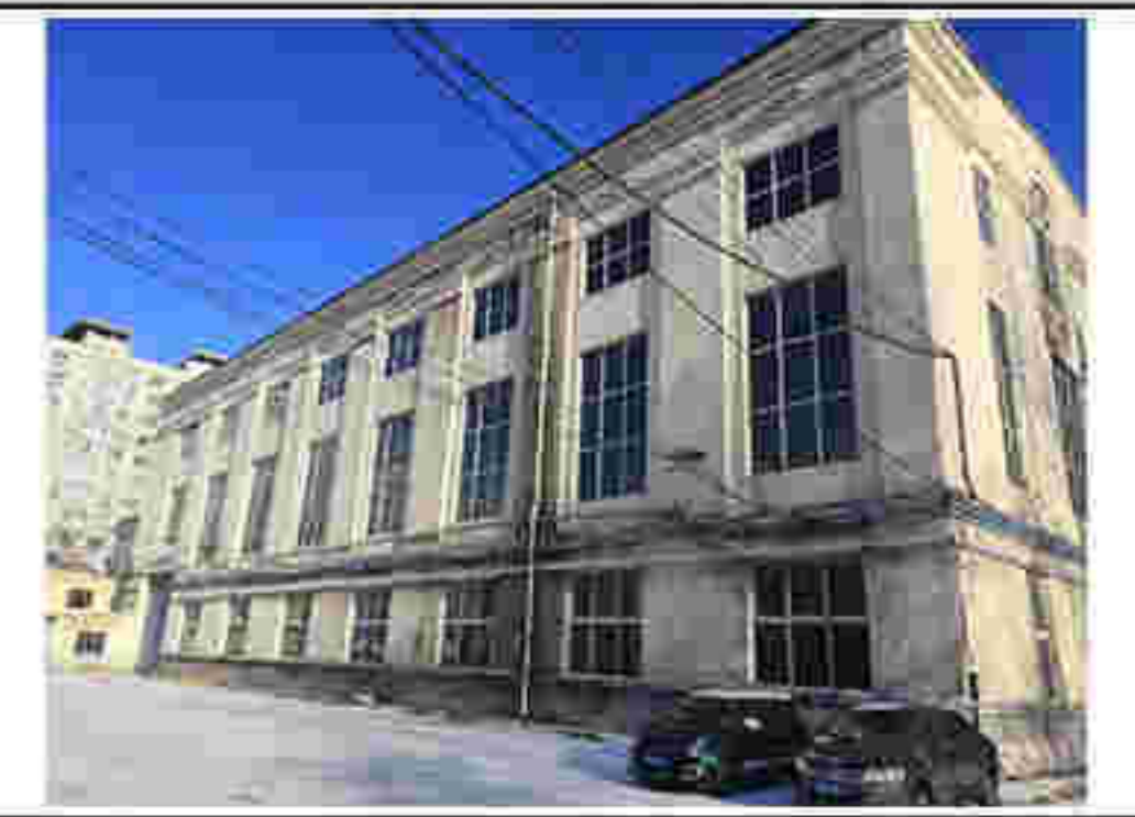
3. 建筑西立面及门窗洞口
