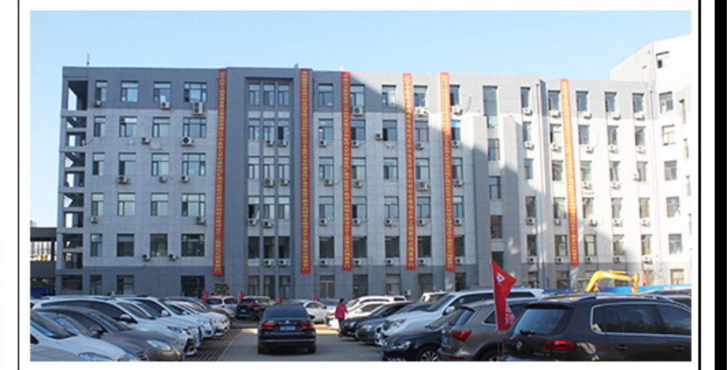
3. 建筑东立面及窗洞口
