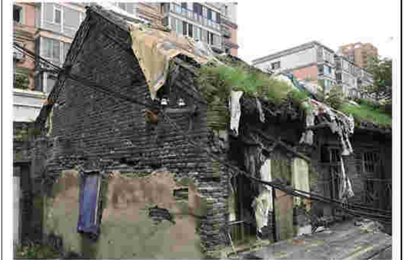
4. 13#南立面、西山墙立面及门窗洞口样式
