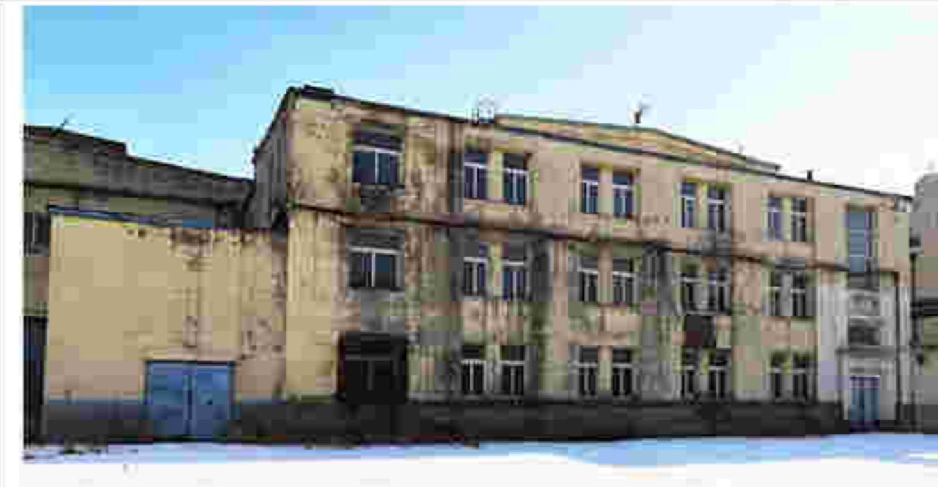
3. 建筑西立面及门窗洞口
