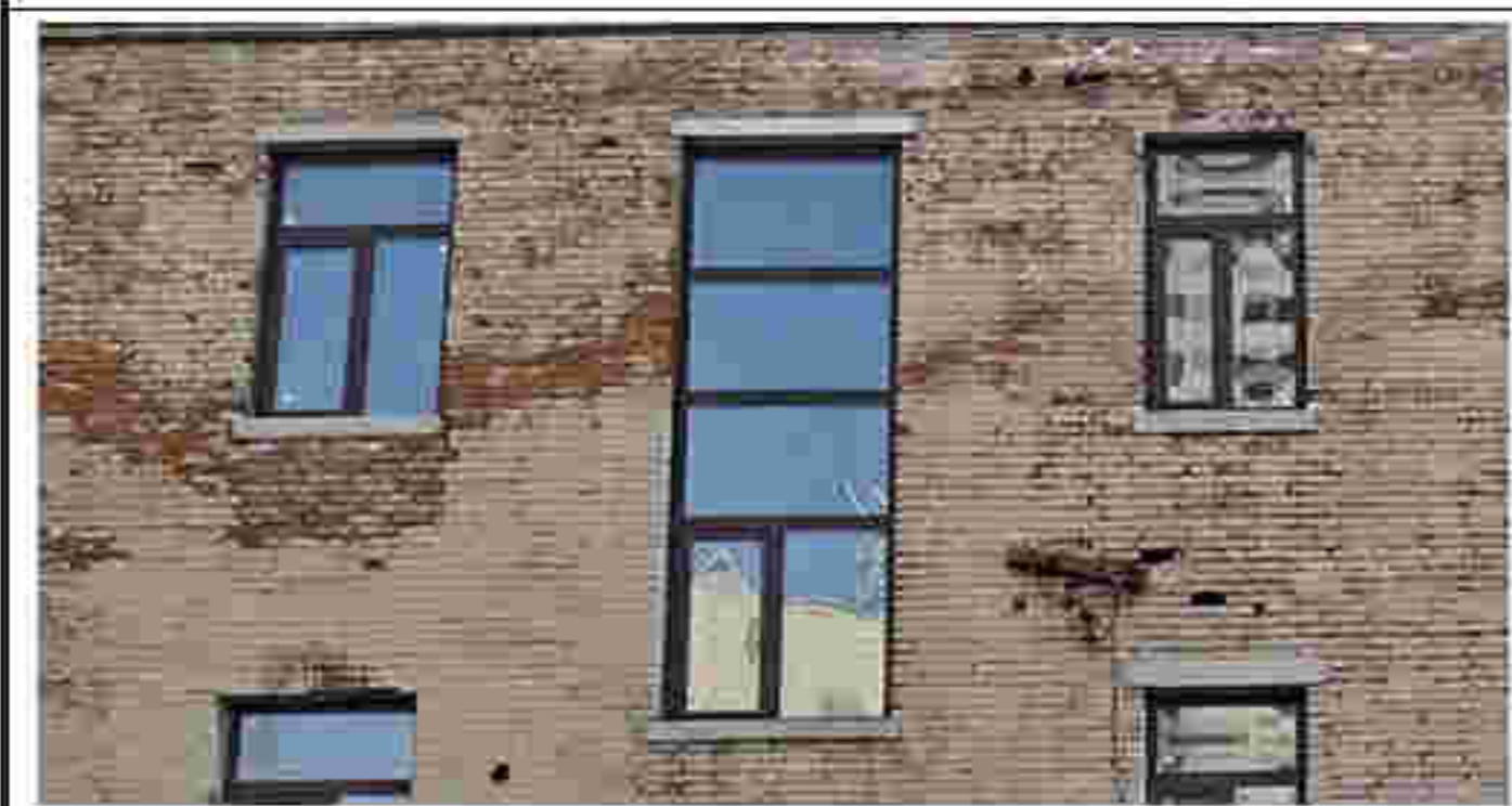
13. 北侧立面窗洞口
