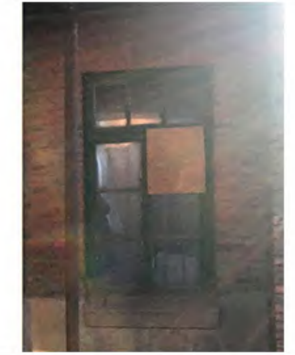
4. 建筑立面窗洞口
