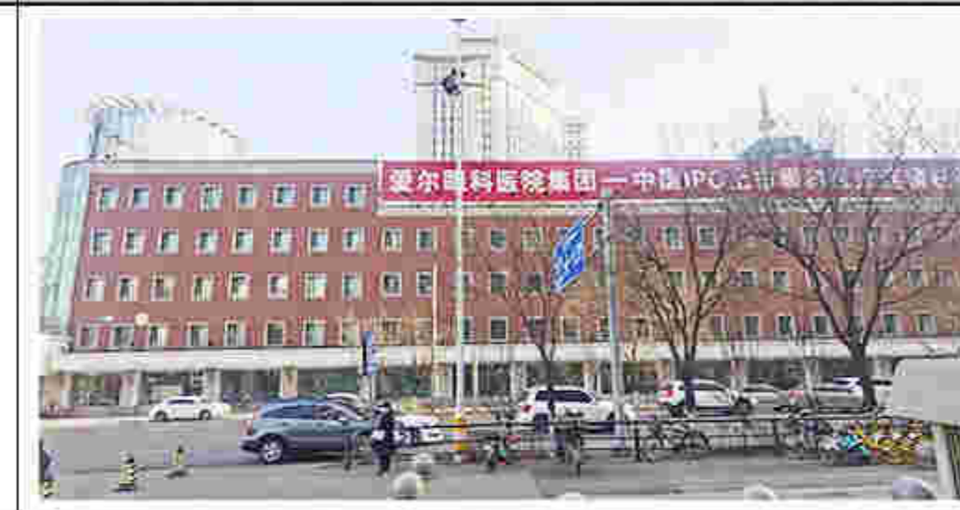
2. 北侧沿街立面及窗洞口
