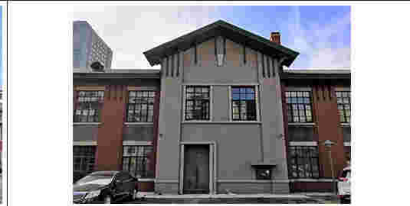
6. 北立面凸出部分山墙
