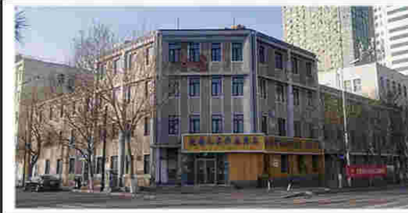
1. 东南侧沿街立面
