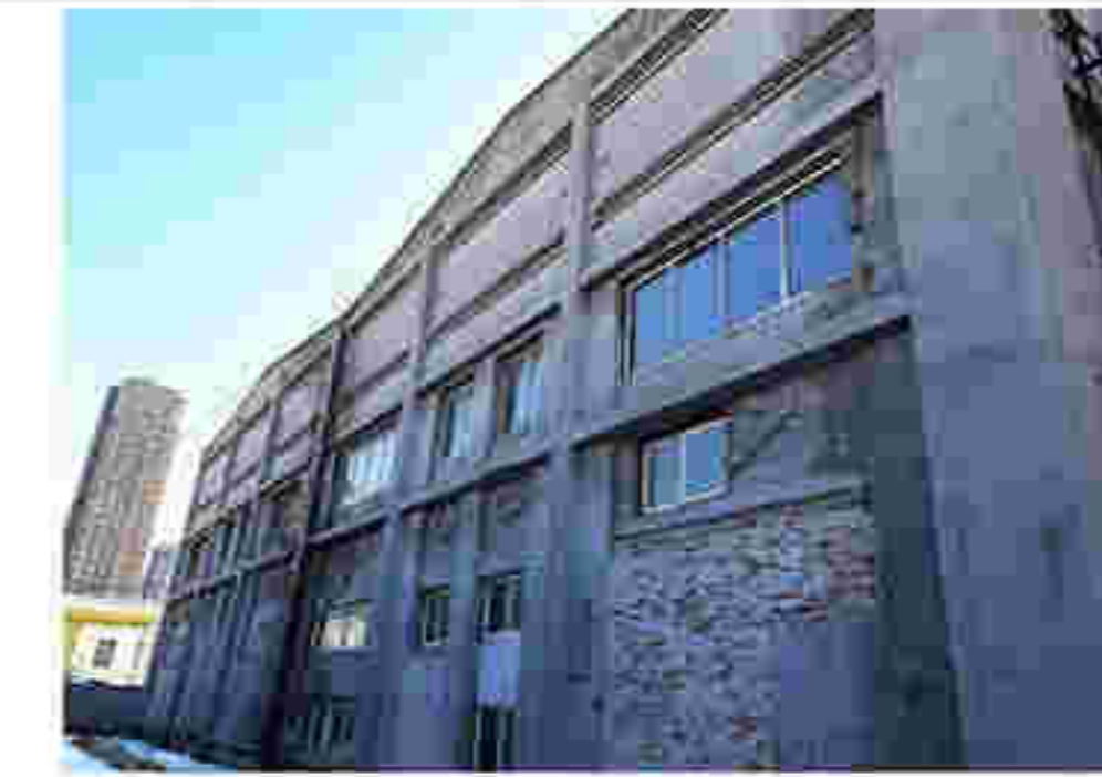
4. 建筑北立面及门窗洞口
