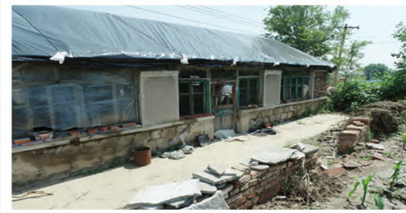
1. 建筑南立面及门窗洞口
