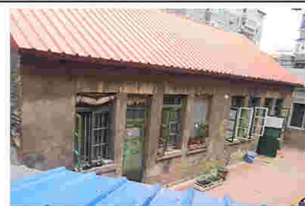
1. 南侧建筑南侧立面建筑及窗洞口
