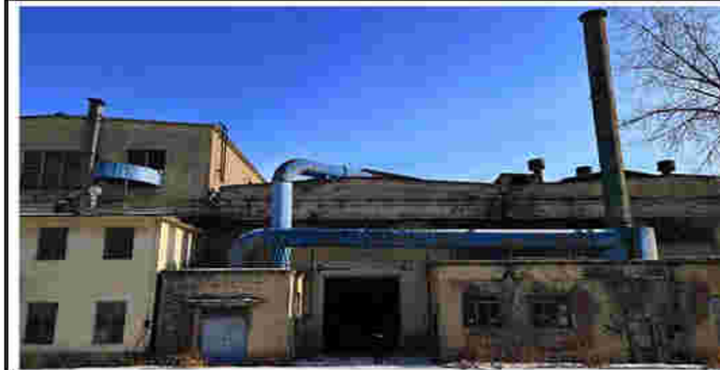
5. 建筑外部管道设施
