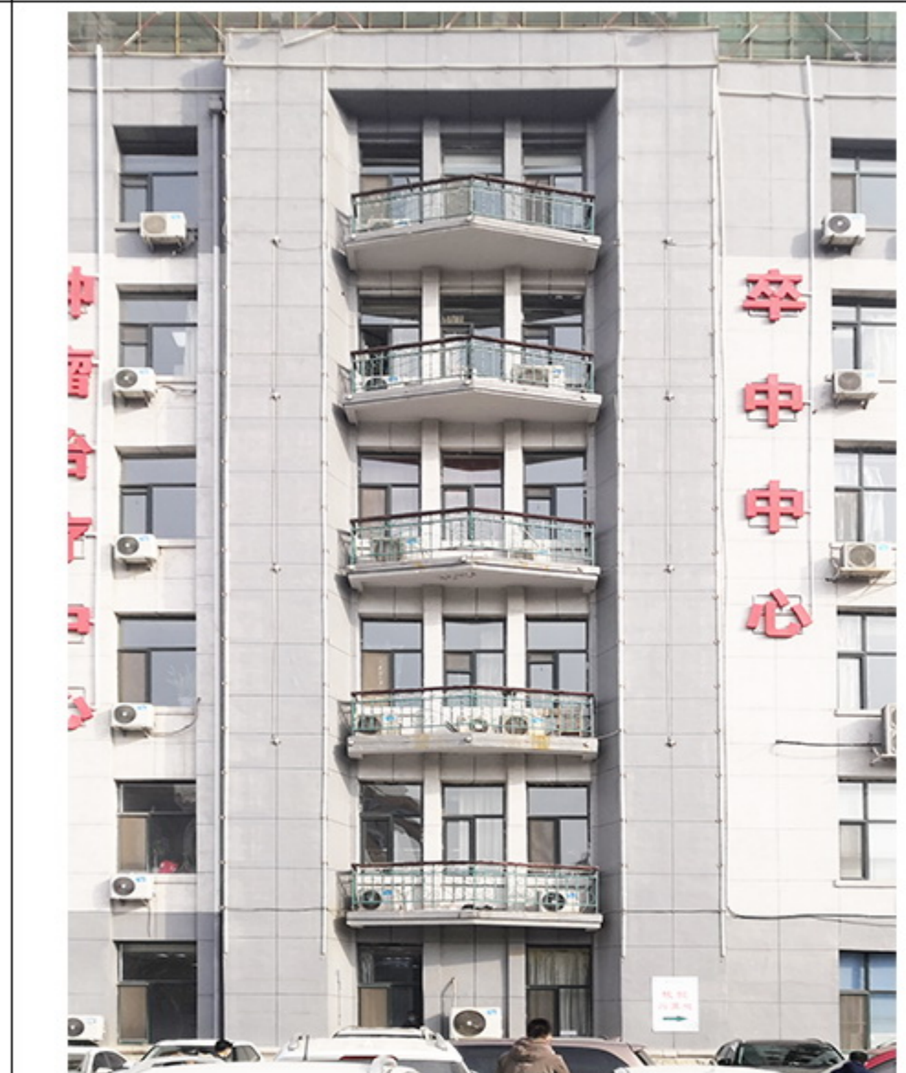
6. 建筑立面片段（二）
