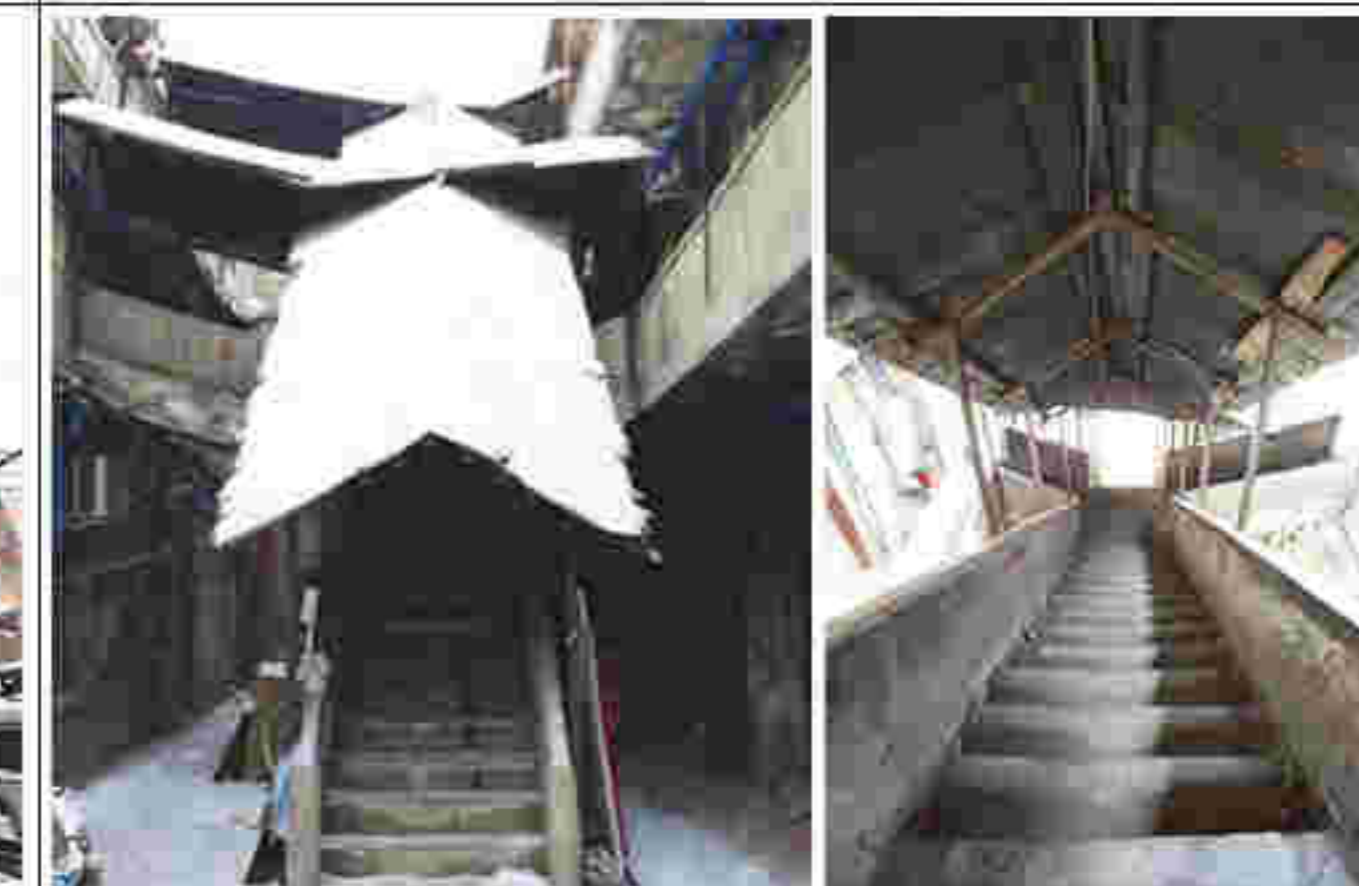
7. 建筑院内室外楼梯
