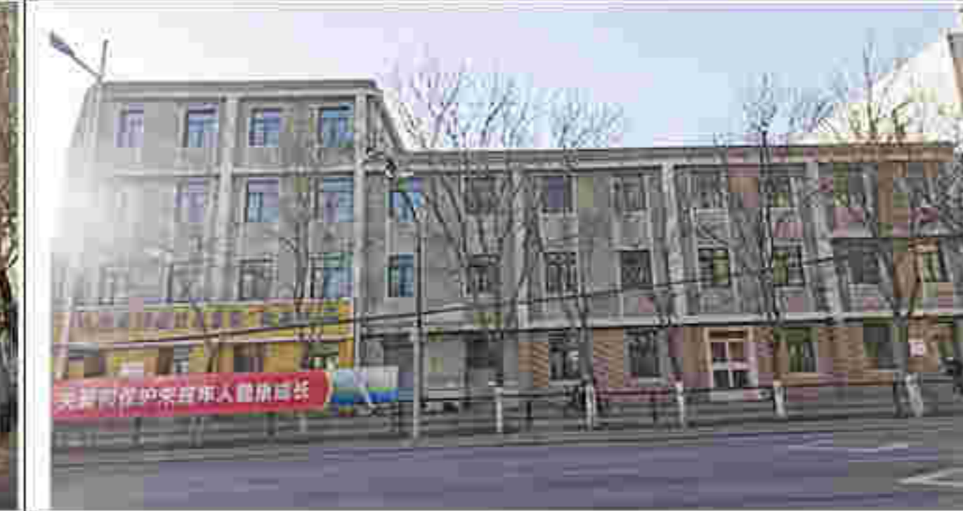
3. 东侧沿街立面
