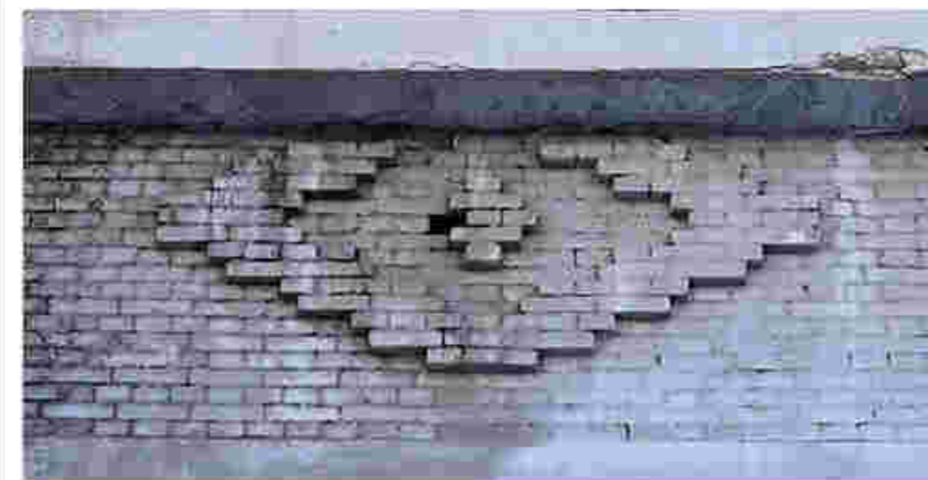
7. 建筑北立面砖砌图案（二）
