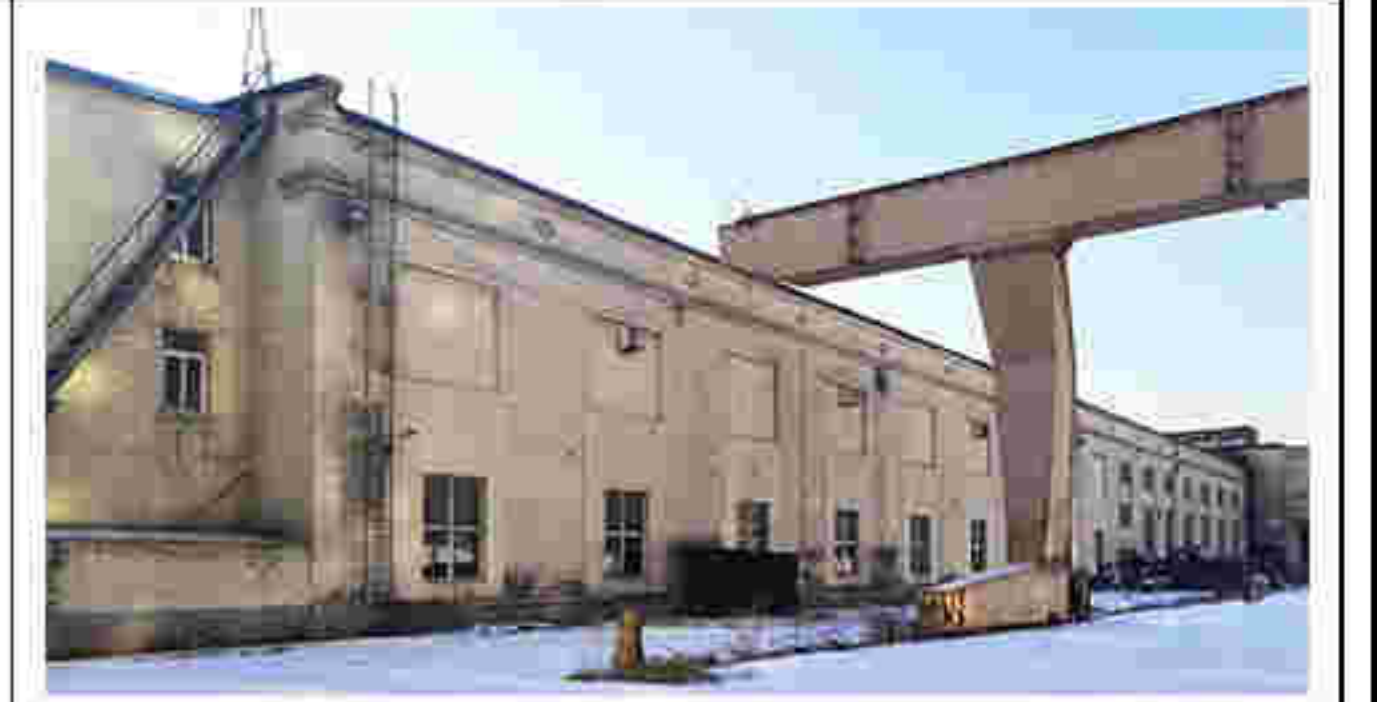
5. 建筑北立面及门窗洞口
