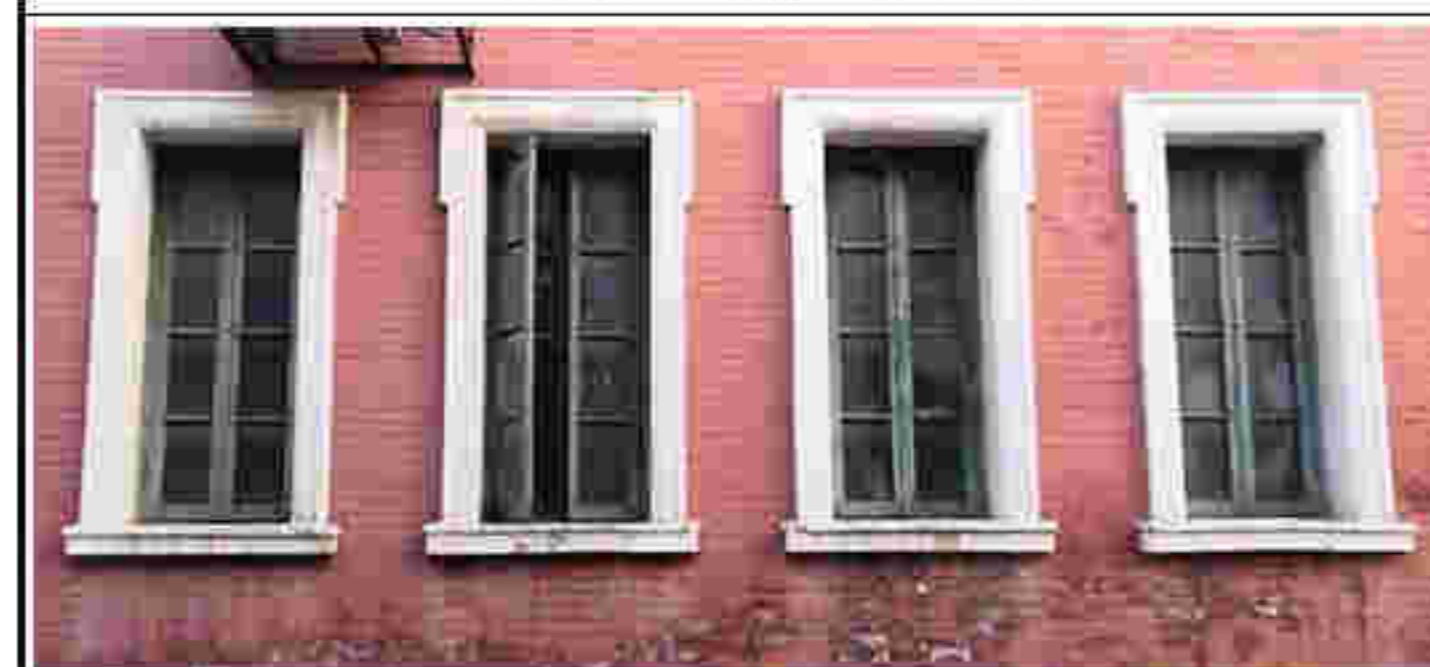
13. 东立面一层窗洞口
