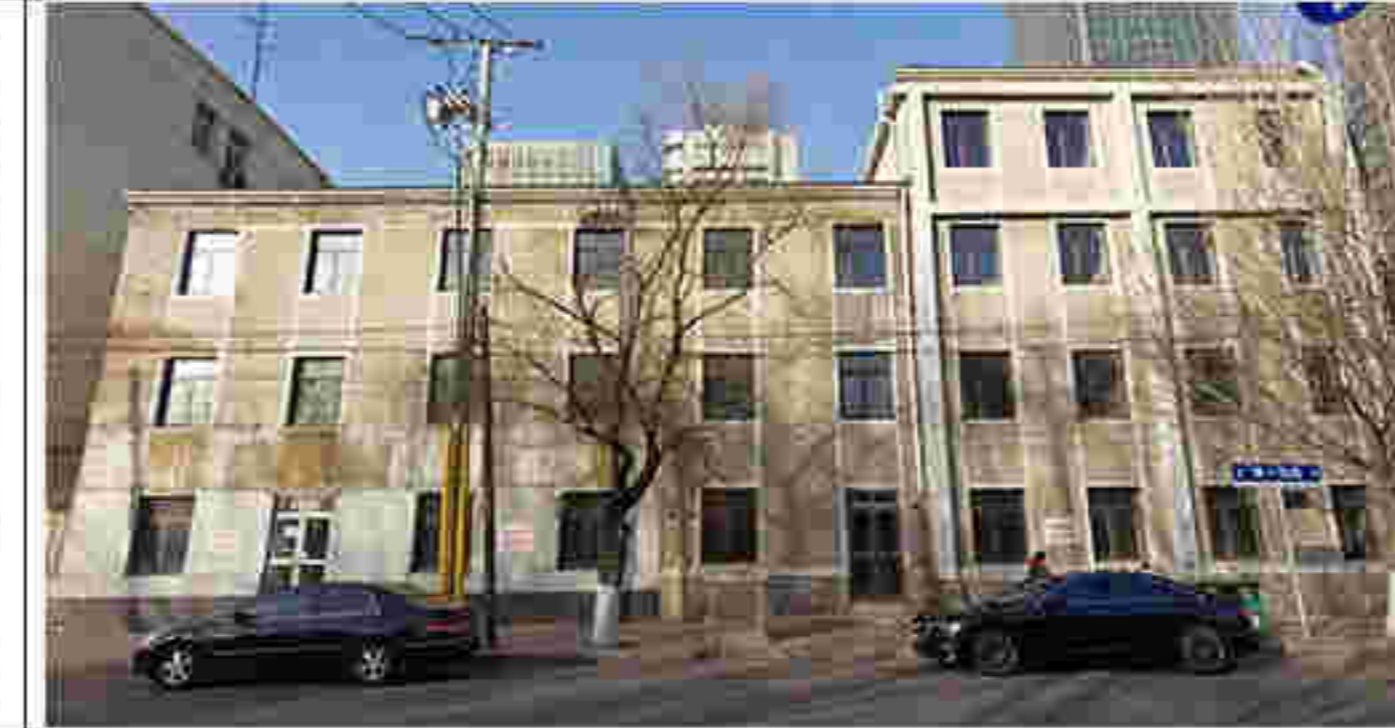
2. 南侧沿街立面
