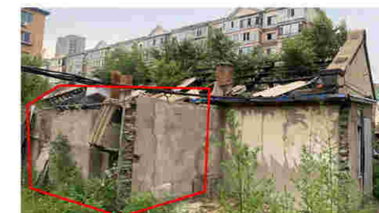
(5#) 北立面加建建筑
