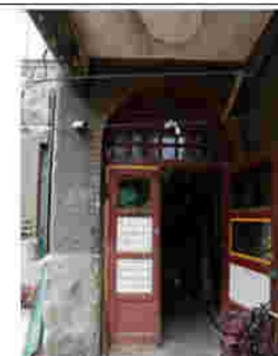
6. 建筑入户门洞口
