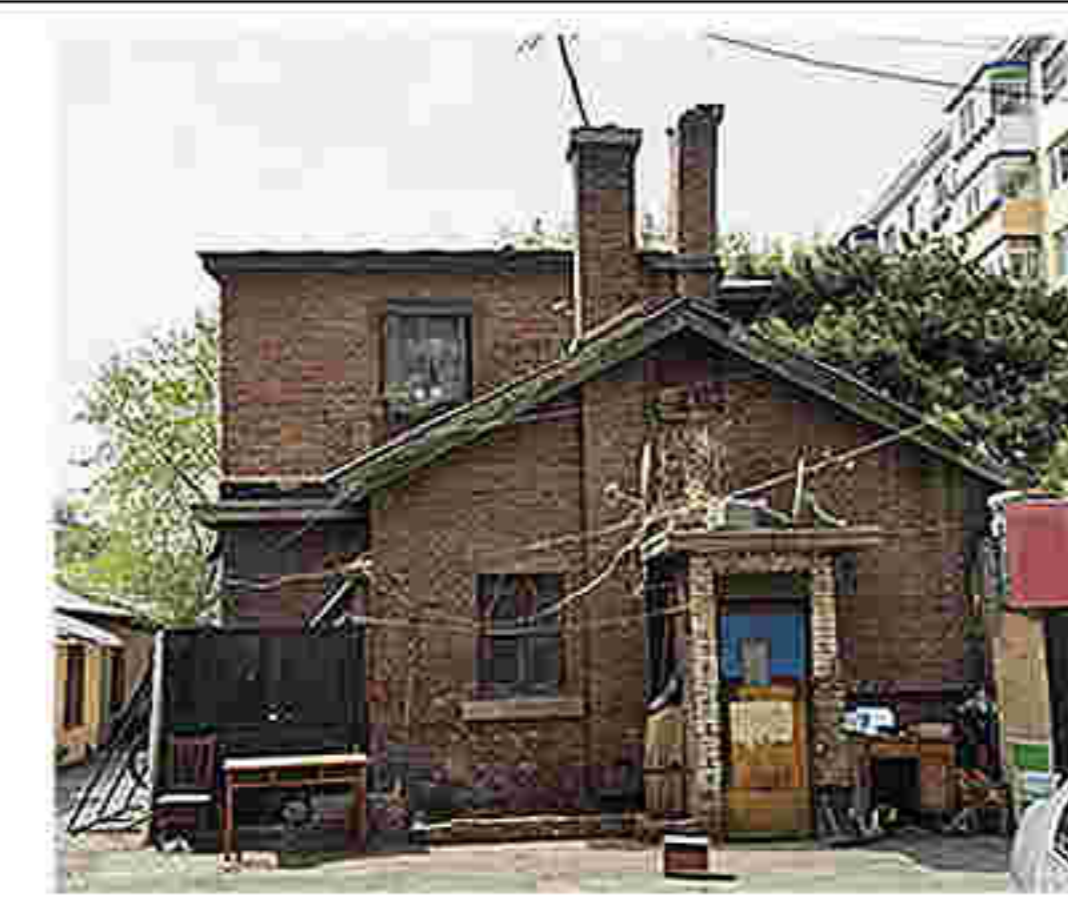
6. 东立面及门窗洞口
