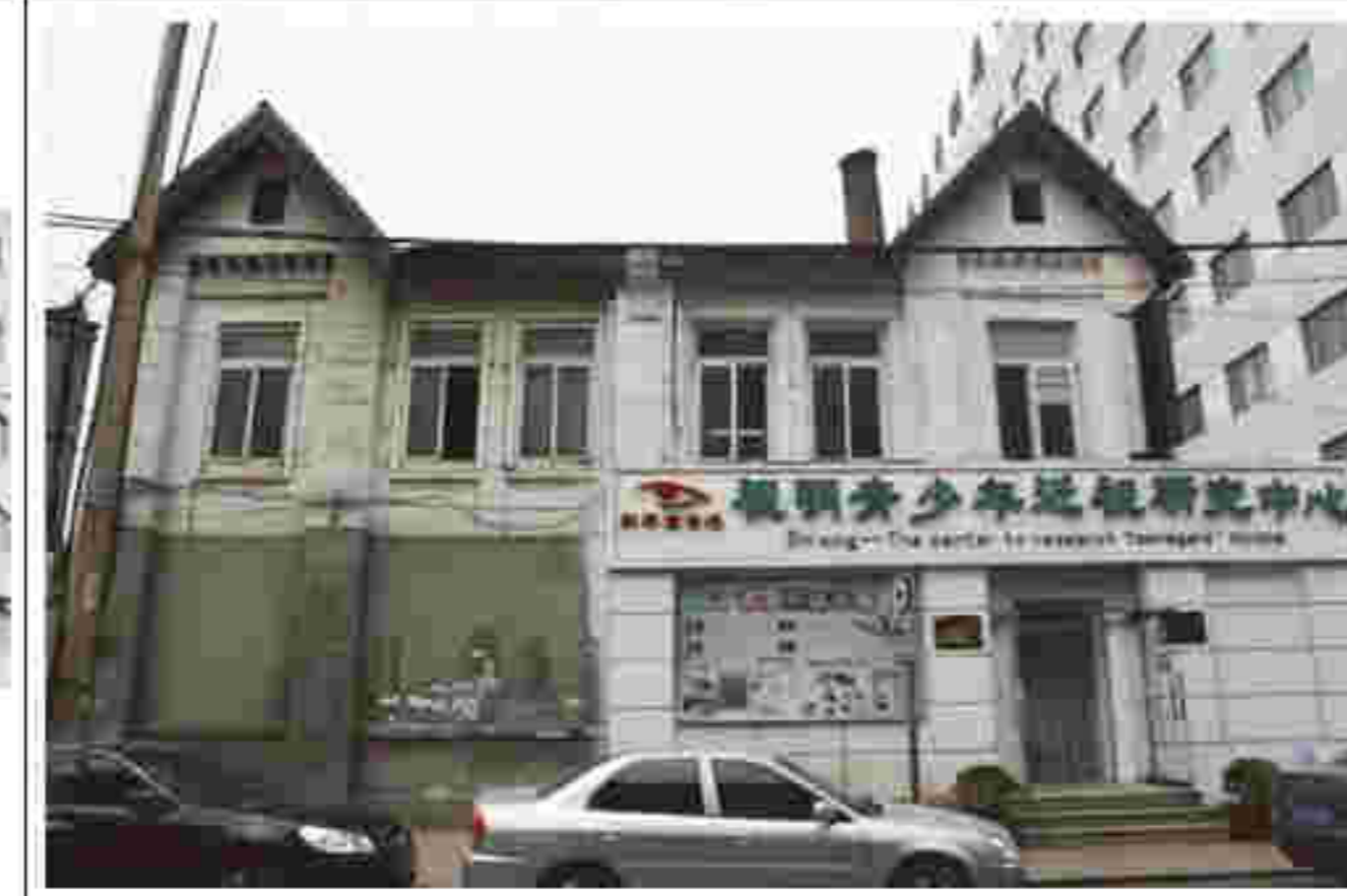
2. 广州街沿街立面及门窗洞口
