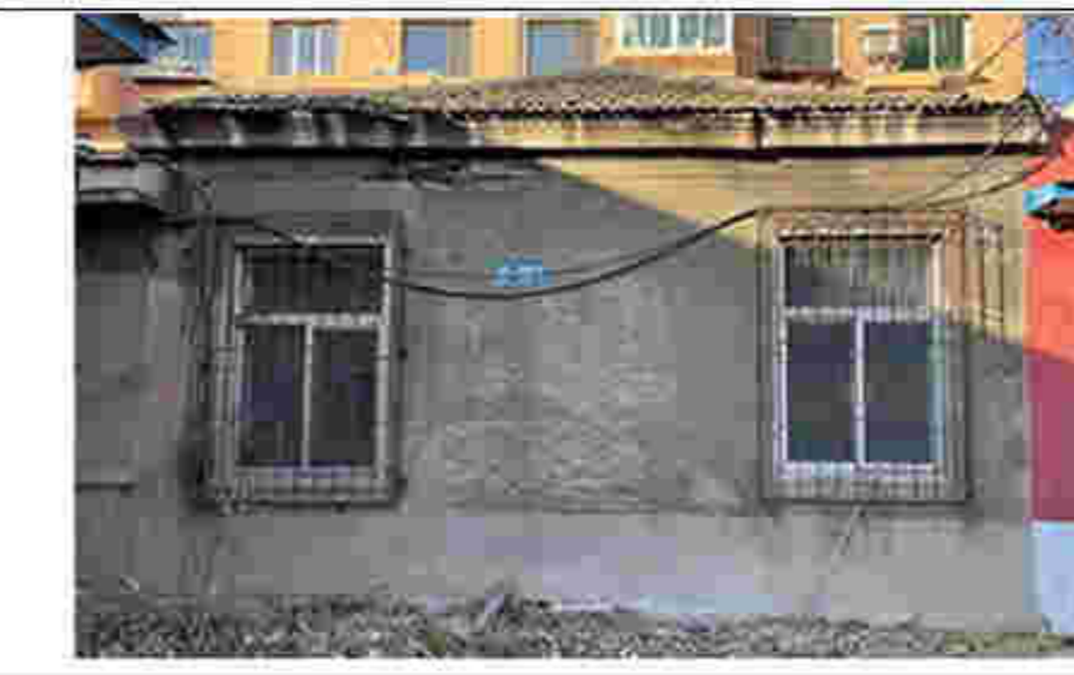
6. (03) 建筑南侧立面
