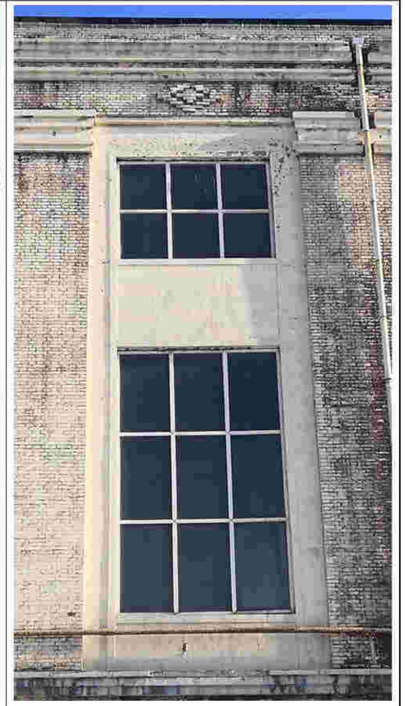
10. 建筑西立面窗洞口
