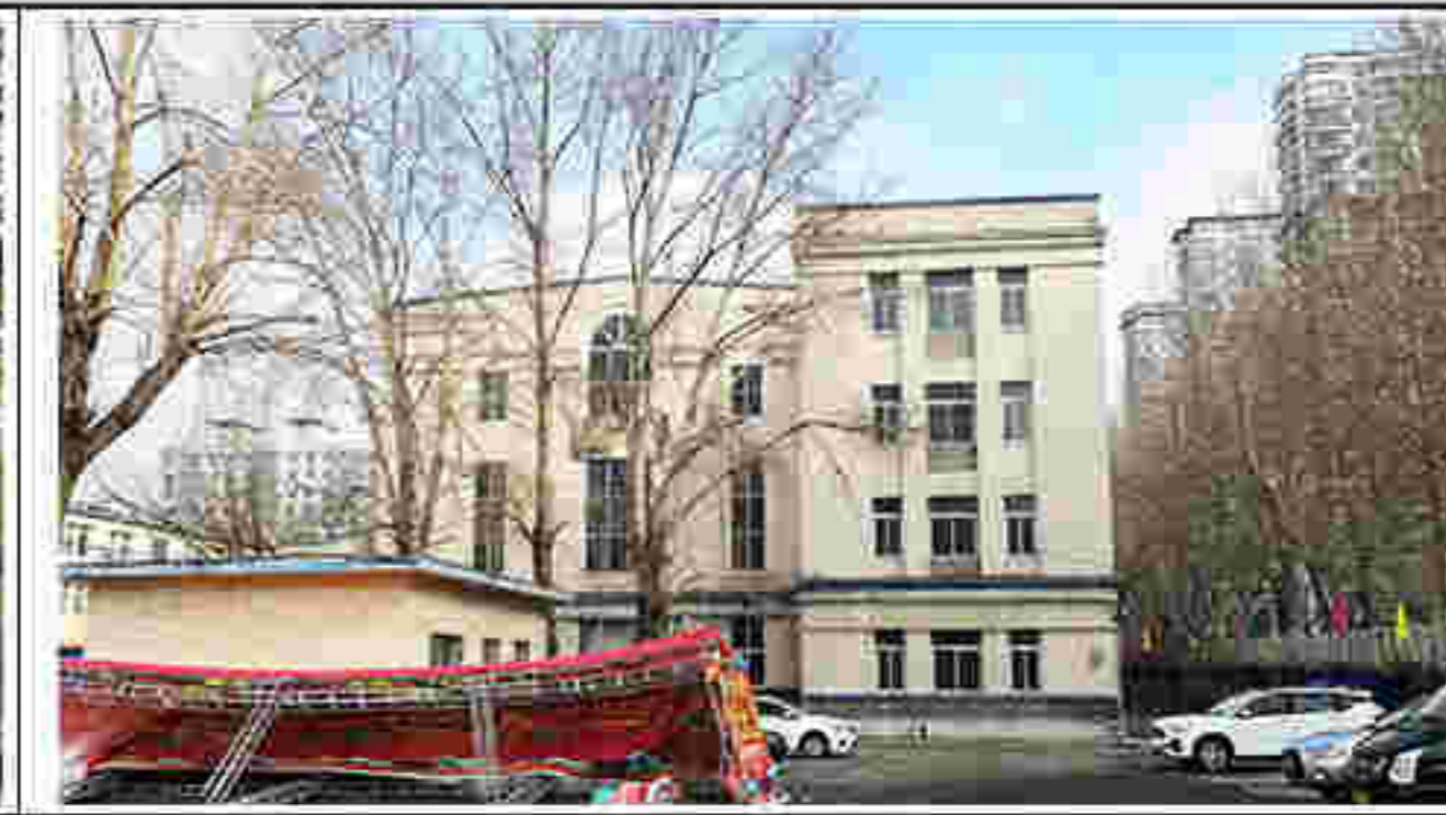
2. 建筑南立面及门窗洞口
