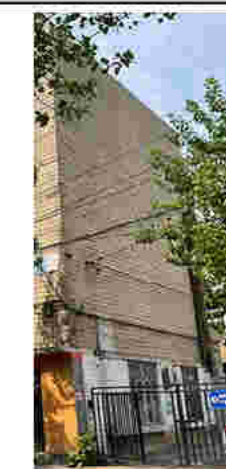
4. 南座建筑东立面
