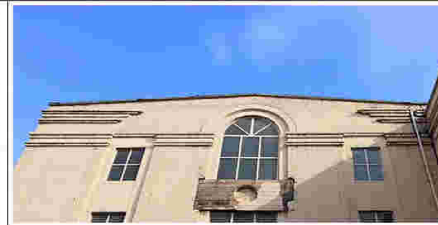
5. 建筑南立面线脚
