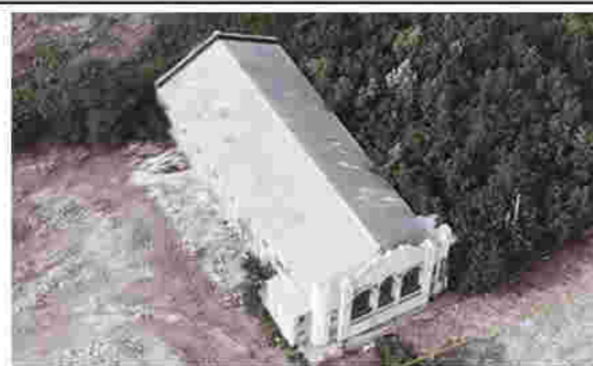
1. 建筑双坡屋顶
