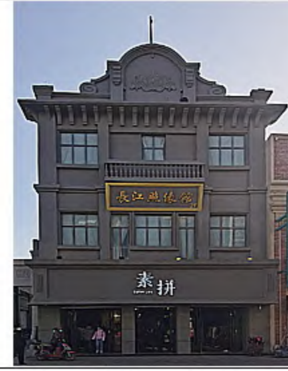
1.北側沿街立面
