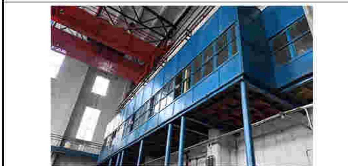
8. 西侧建筑吊车及操作台
