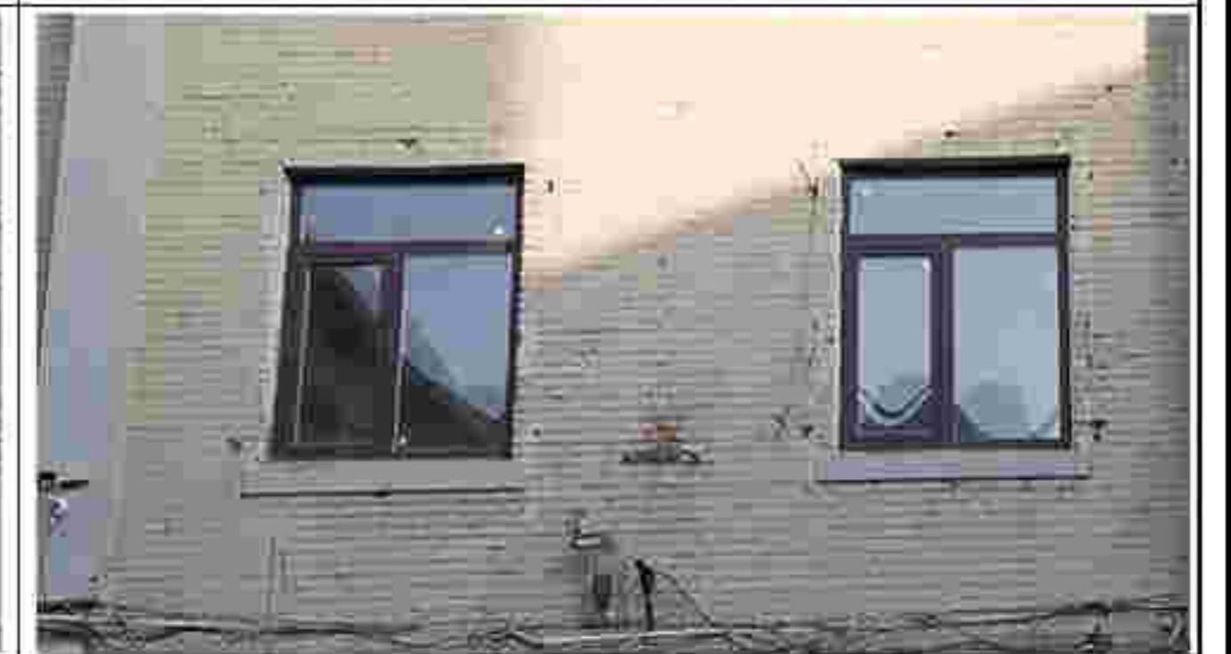
12. 西侧立面窗洞口
