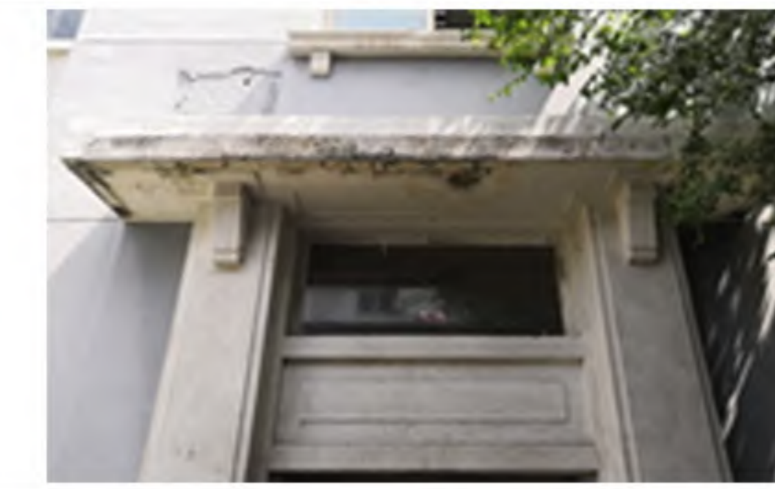
7. 建筑西立面入口门头
