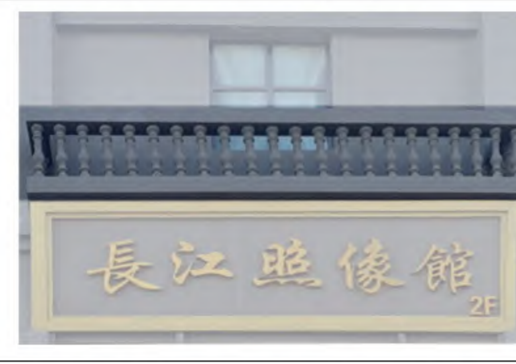
2.北側沿街立面二层阳台栏杆
