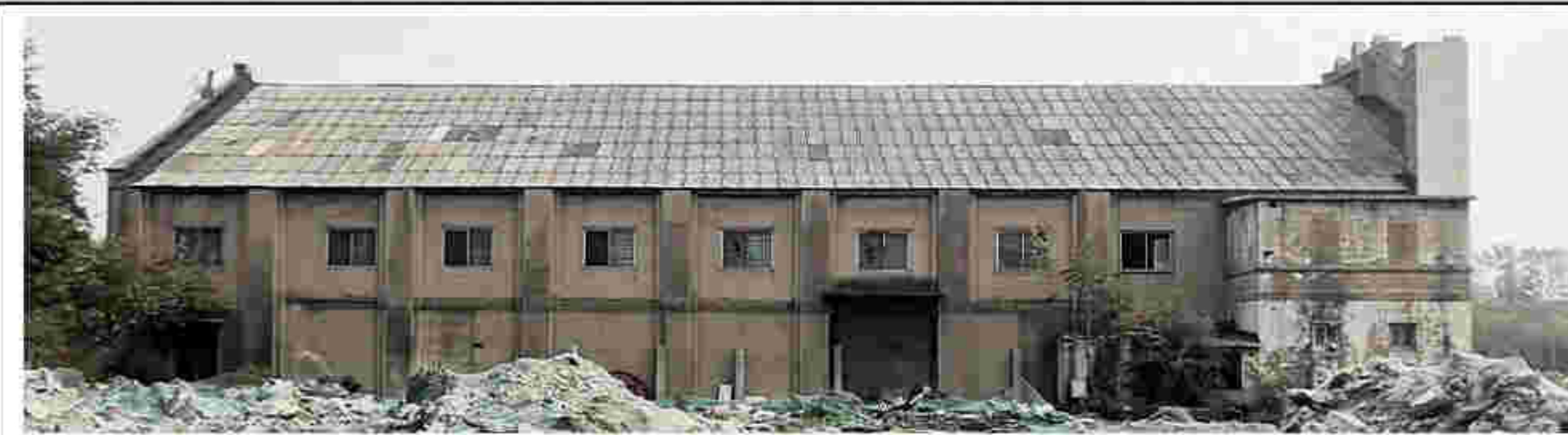
3. 建筑东、西立面及壁柱
