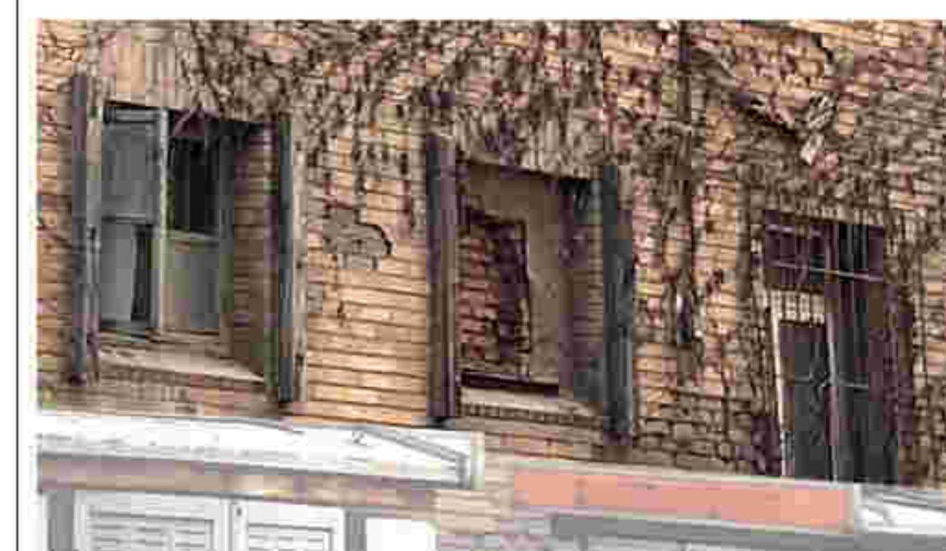
8. 北三马路沿街立面窗洞口2
