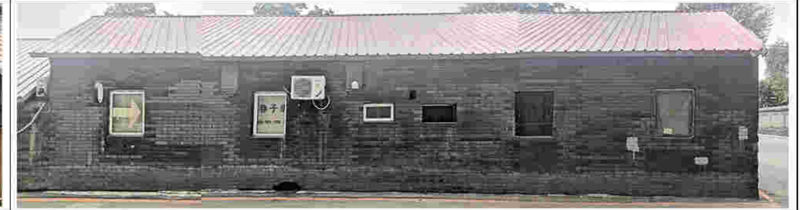
2. 北侧立面及窗洞口
