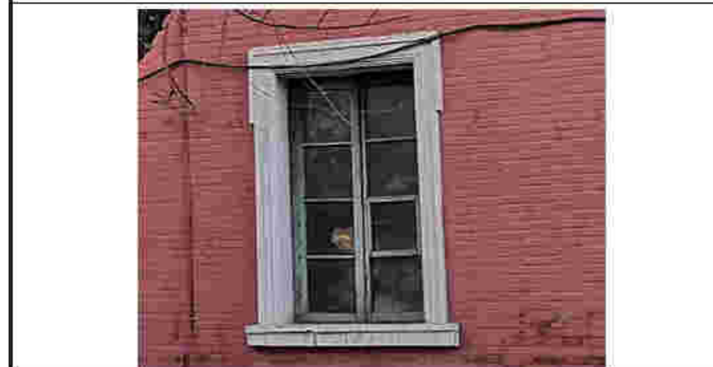
9. 北立面一层西侧窗洞口
