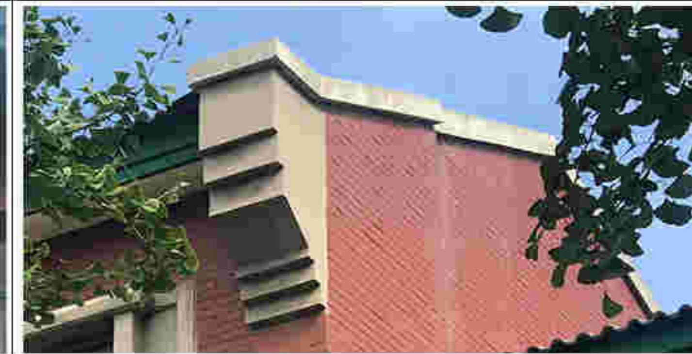
10. 建筑交接处山墙墙头
