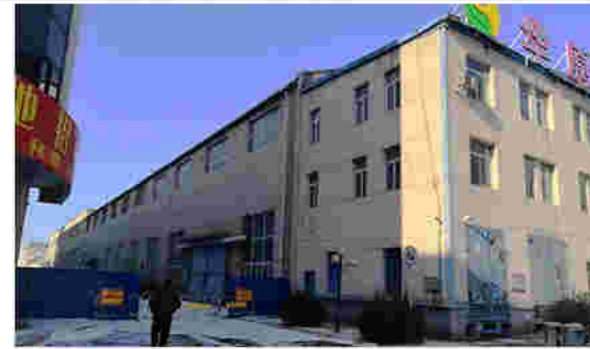
2. 建筑南立面及门窗洞口
