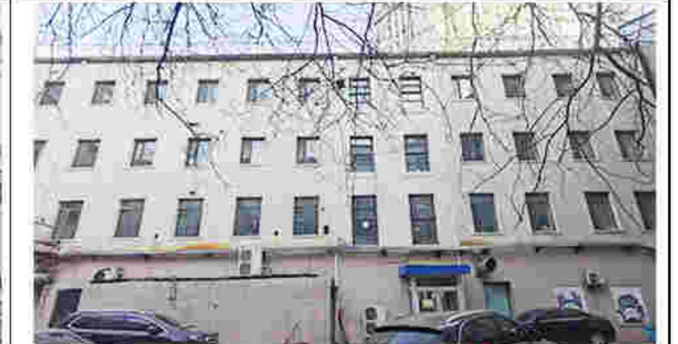
8. 西立面及窗洞口（内部）
