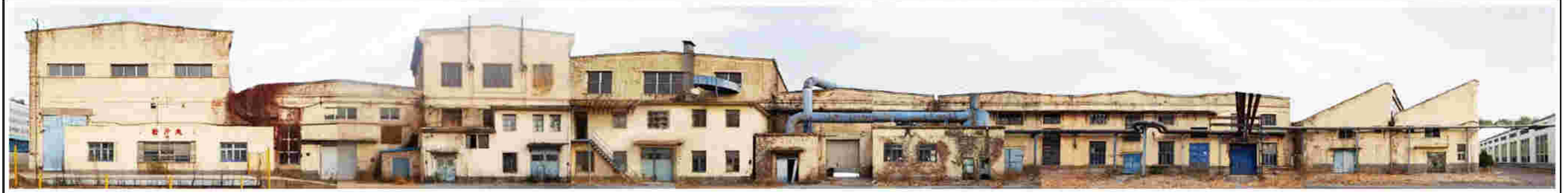
1. 建筑西立面及门窗洞口
