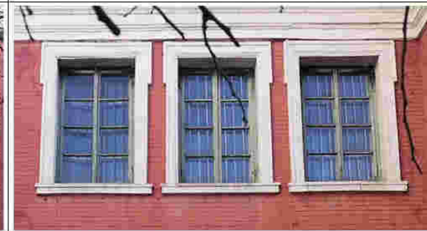
11. 北立面二层西侧窗洞口
