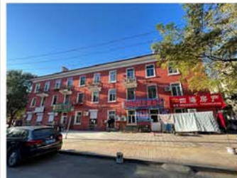
4. 建筑山墙面及窗洞口1
