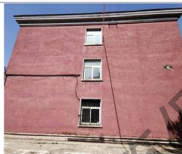
4. 东西侧立面及其门窗洞口
