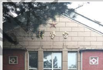
6. 建筑西立面三角形山花、雕花、科学宫字样
