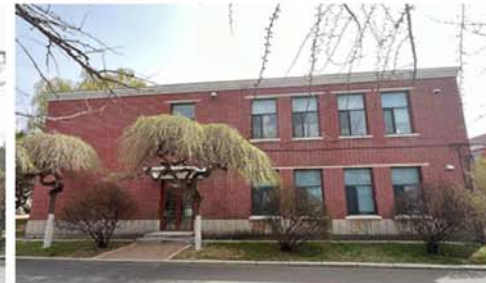
4. 建筑西立面及其门窗洞口
