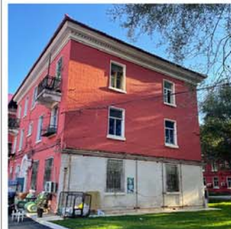
5. 建筑山墙面及窗洞口2
