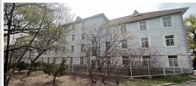
5. 建筑北立面及其门窗洞口
