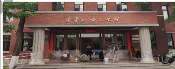
5. 建筑南立面主入口
