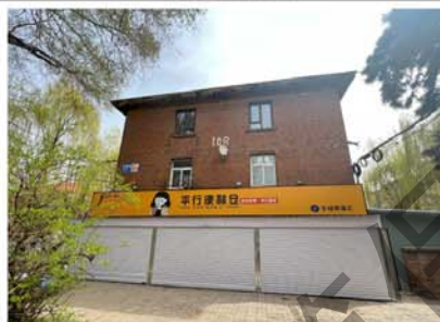
4. 建筑西立面及其窗洞口
