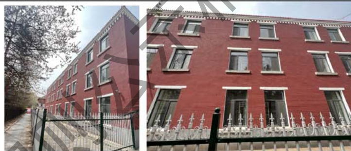
2. 建筑东立面及其窗洞口
