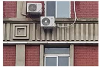
11. 建筑东立面装饰构件2
