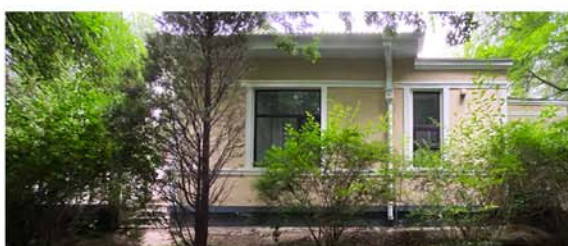
8. 侧(东)立面转折形态、洞口形式及横向装饰线脚
