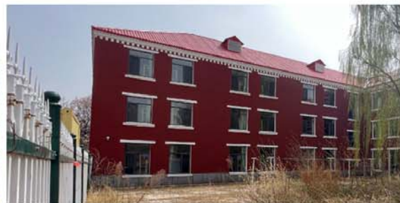
4. 建筑西立面及其门窗洞口
