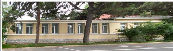
5. 背(北)立面门窗洞口及横向线脚形式
