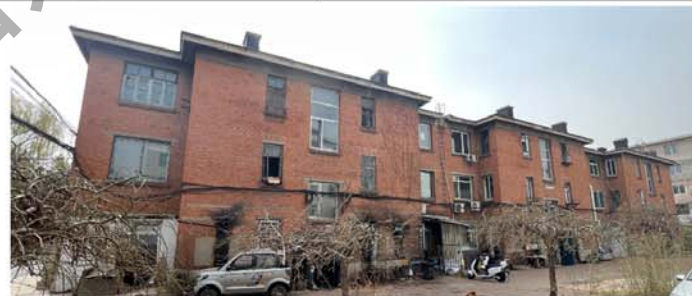
5. 建筑北立面及其门窗洞口
