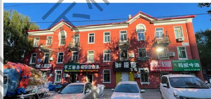
3. 建筑沿街立面及门窗洞口
