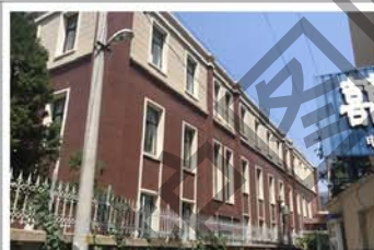
4. 建筑东立面及洞口尺度
