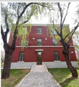
4. 建筑西立面及其门窗洞口
