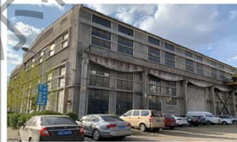
3. 建筑东立面及结构柱
