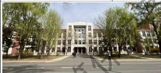
3. 建筑南立面及其门窗洞口
