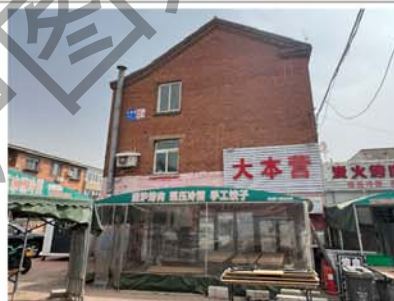
4. 建筑西立面及其门窗洞口
