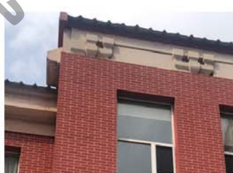
8. 南立面入口处屋顶水平装饰线脚及雕花
