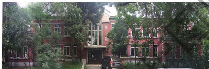
3. 建筑西立面纵向五段式构图及门窗洞口
