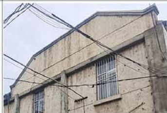
8. 建筑东西立面山墙及线脚
