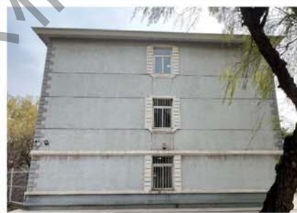
3. 建筑西立面及其门窗洞口
