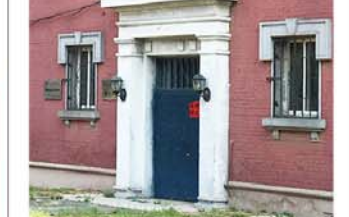
8. 北立面主入口门洞、门套及窗套
