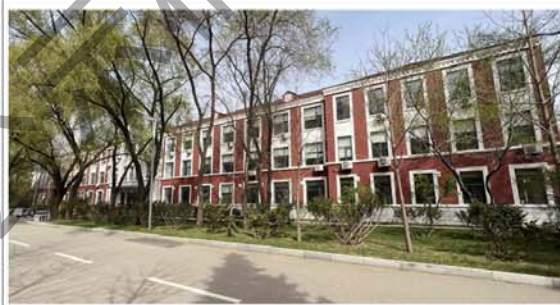
3. 建筑南立面及其门窗洞口
