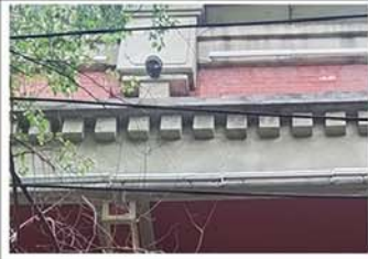
12. 建筑东立面装饰构件3
