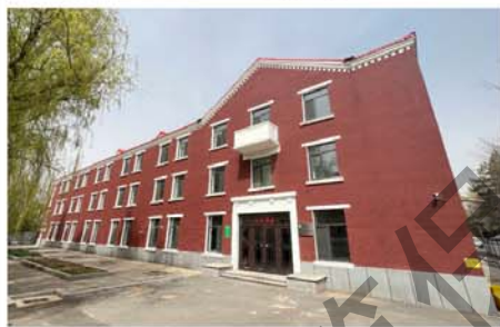
3. 建筑南立面及入口窗洞口
