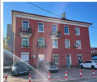
5. 建筑山墙面及窗洞口2
