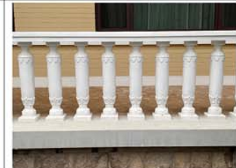
11. 建筑外廊栏杆扶手
