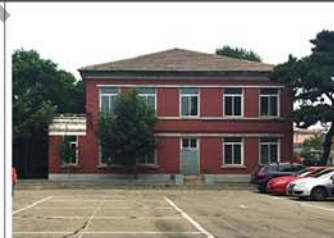
2. 建筑南立面及门窗洞口
