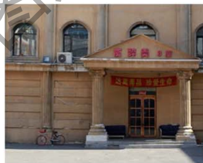
4. 西侧面窗洞口
