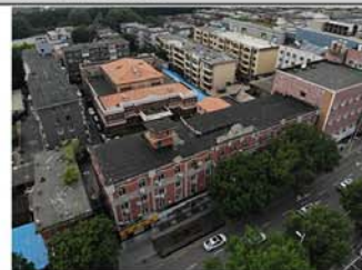
1. 建筑平屋顶及水平挑檐
