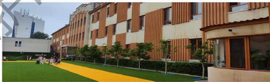
5. 北侧建筑南立面（与南侧建筑南立面相同）
