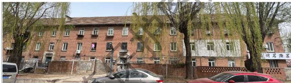
3. 建筑南立面及其门窗洞口
