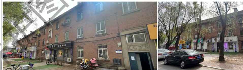
5. 建筑北立面及其门窗洞口
