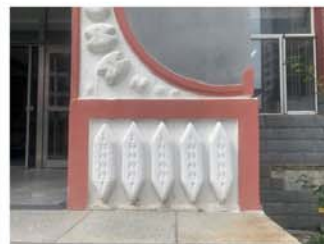
12. 南立面主入口门洞浮雕-2
