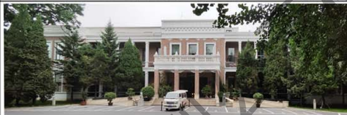
2. 建筑南立面及门面、外廊、入口、坡道形式
