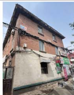
2. 建筑东立面及北窗洞口
