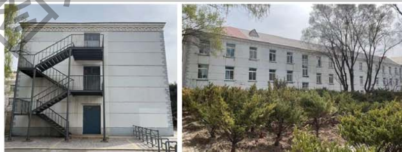
4. 建筑西立面及其门窗洞口
