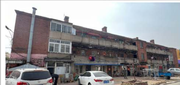
5. 建筑北立面及其门窗洞口
