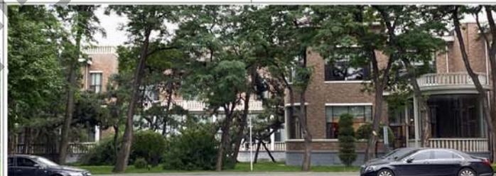
6. 侧(东)立面转折形态及洞口形式
