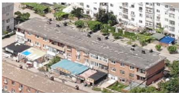
1. 建筑屋顶及烟囱
