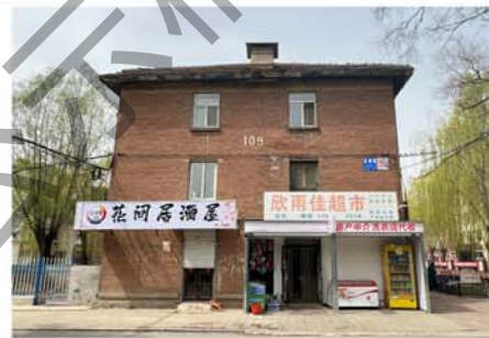
2. 建筑东立面及其门窗洞口
