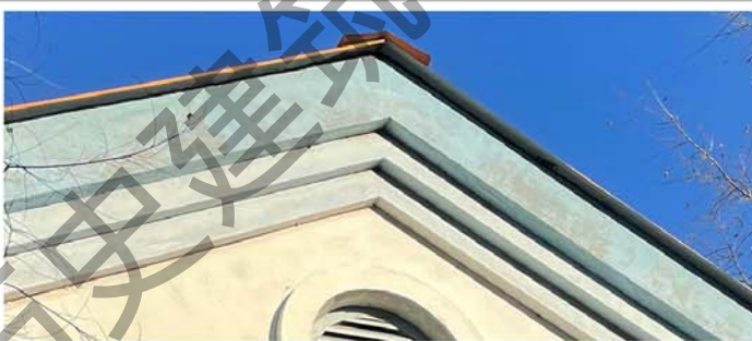
4. 山墙面屋顶多层檐口
