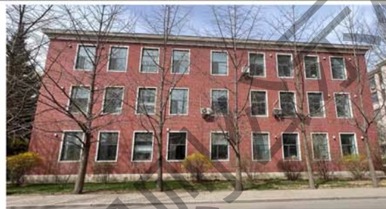
2. 建筑东立面及其门窗洞口
