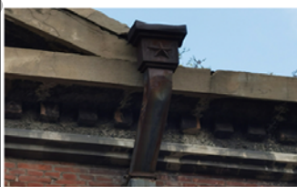
14. 建筑西侧立面排水管
