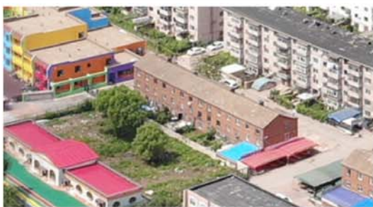
1. 建筑屋顶及烟囱
