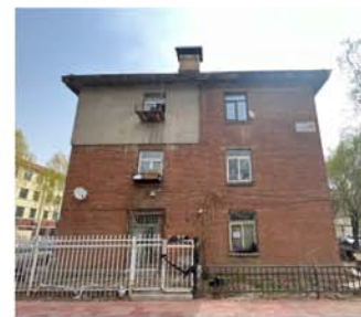
4. 建筑西立面及其门窗洞口
