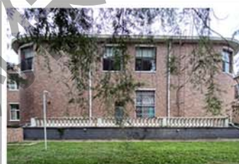
8. 背(北)立面两侧体块形态及楼梯细部
