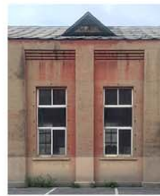
6. 西立面壁柱及窗洞口
