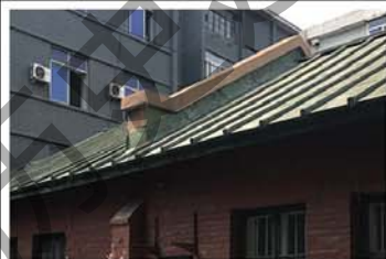
8. 建筑屋顶外露斜梁
