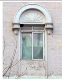
6. 建筑南立面中部带雕饰窗户形式
