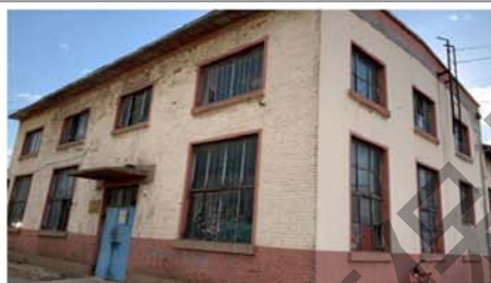
4. 建筑门窗样式
