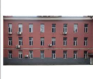
6. 建筑北立面局部
