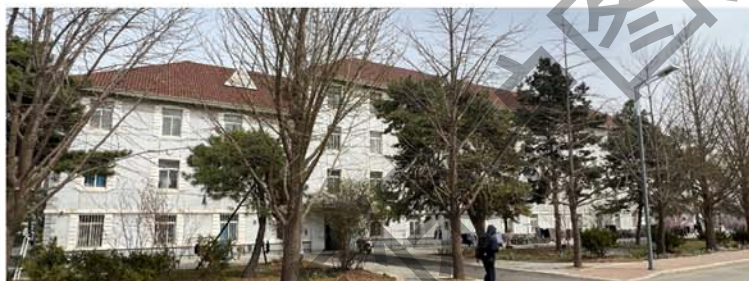
4. 建筑南立面及其门窗洞口
