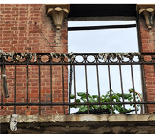
11. 西侧立面二层阳台栏杆
