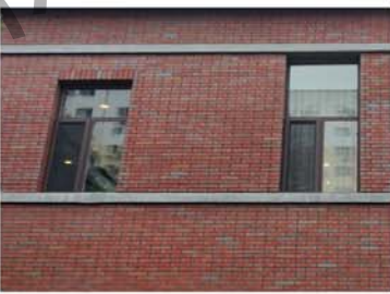
9. 北立面中楼二层西侧窗户样式及装饰线脚
