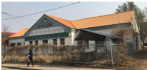
4. 山墙面屋顶多层檐口
