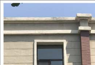
6. 建筑檐口及水平向装饰线脚（一）
