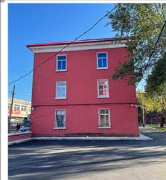
4. 建筑山墙面及窗洞口1
