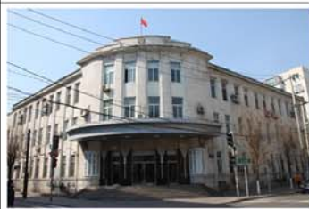
3. 建筑东南角弧形立面形式及门窗洞口尺度
