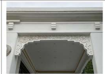
8. 建筑主入口多层檐口及装饰浮雕
