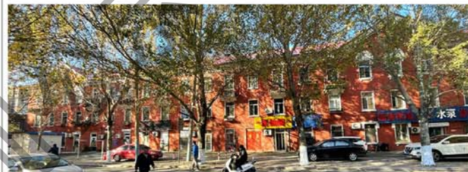
2. 建筑沿街立面及门窗洞口
