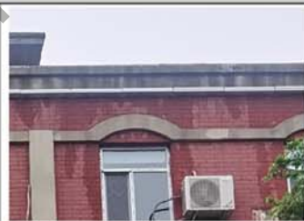
4. 建筑东立面水平装饰线脚
