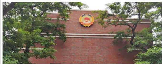
8. 南立面主入口顶部装饰线脚及馆徽
