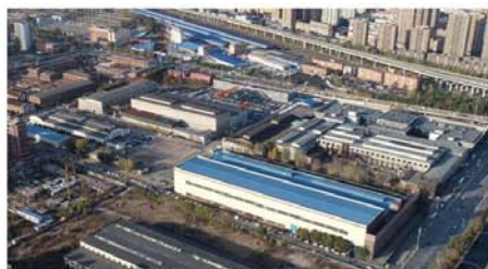
厂区航拍照片
