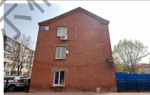
3. 建筑西立面及其窗洞口
