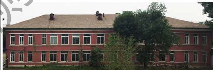
4. 建筑东立面及门窗洞口
