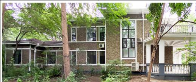
6. 侧(西)立面转折形态、洞口形式、外廊及横向装饰线脚
