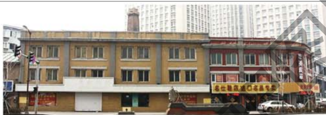
3. 建筑中山路沿街立面
