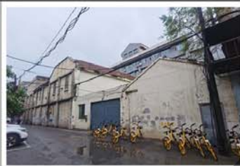
2. 建筑局部双坡屋顶
