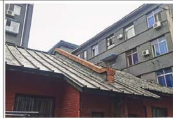
8. 建筑屋顶外露斜梁
