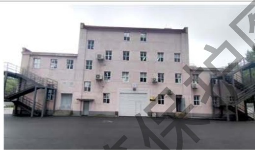
3. 建筑西立面及门窗洞口
