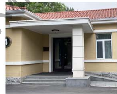
3. 建筑主入口门廊及檐口线脚
