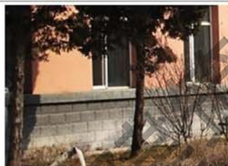
6. 建筑南立面勒脚
