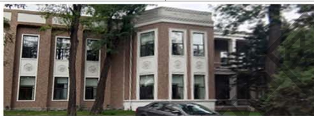
4. 南立面两个凸窗形式、体量及门窗洞口形式
