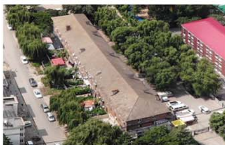
1. 建筑屋顶及烟囱
