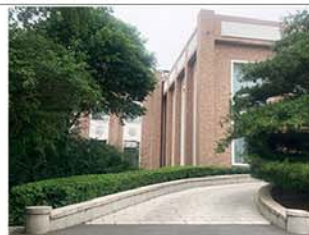
9. 东立面入口坡道
