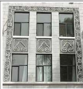
8. 建筑南立面窗洞口周边装饰
