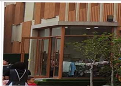
10. 南侧建筑南立面入口样式
