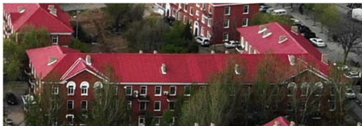
1. 建筑U型平面布局及四坡屋顶
