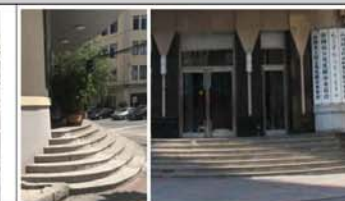
14. 建筑入口弧形台阶
