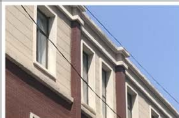
9. 建筑立面壁柱形式（二）
