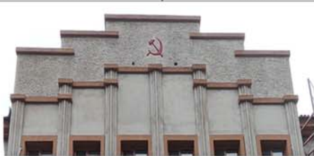
12. 建筑南立面壁柱及徽章
