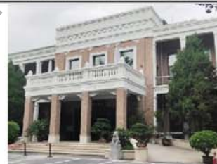
3. 南立面主入口多层线脚及丰富雕饰
