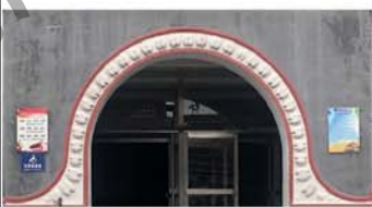
11. 南立面主入口门洞浮雕-1
