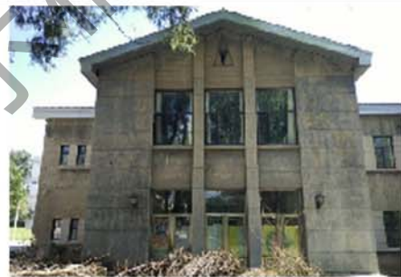
3. 北侧建筑西立面
