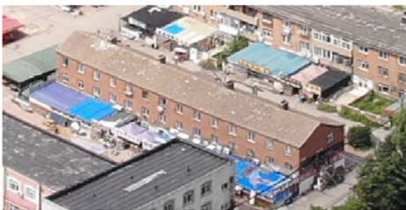
1. 建筑屋顶及烟囱
