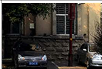
12. 建筑南立面勒脚
