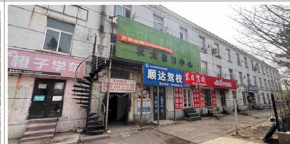
5. 建筑西立面及其门窗洞口
