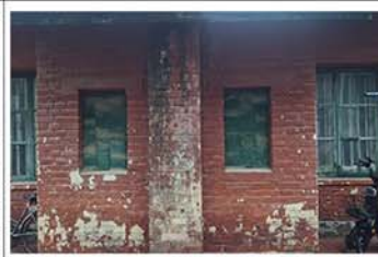
10. 建筑北立面壁柱
