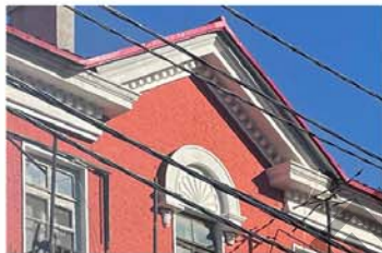
2. 屋顶檐口、窗洞口装饰
