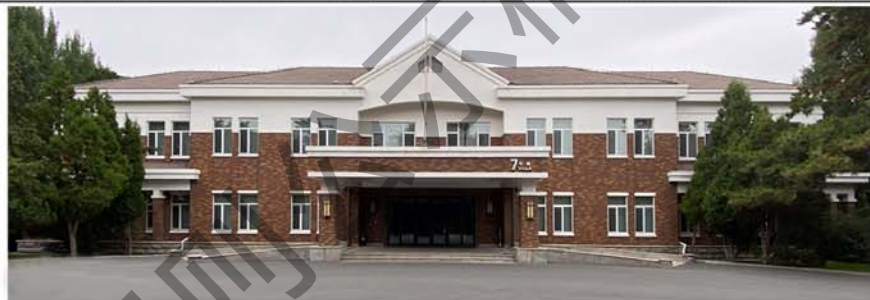
2. 正(副)立面对称造型、门窗洞口形式、首层外廊及横向装饰线脚
