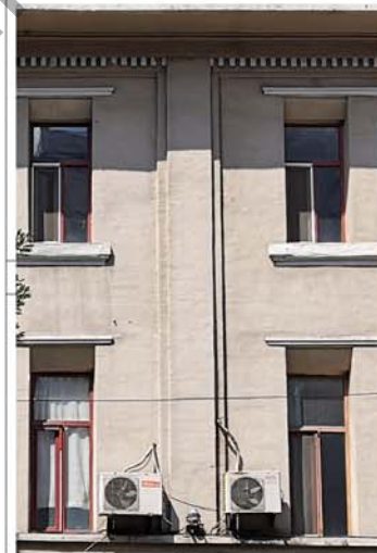
4. 建筑南立面壁柱
