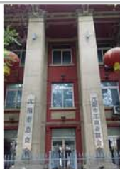
5. 建筑东立面门柱
