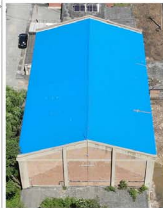
2. 建筑山墙及壁柱
