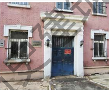
7. 北立面中部入口门洞、门套及窗套
