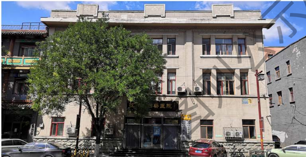
1. 建筑南立面及门窗洞口
