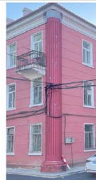
6. 建筑立面转角多立克柱式
