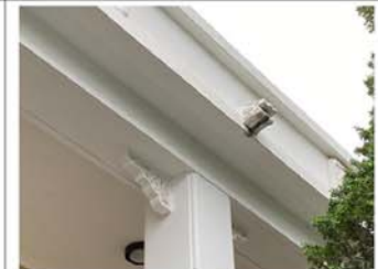
12. 外廊檐口细节多层脚线
