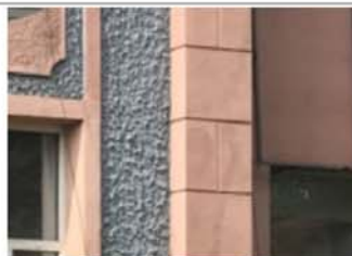
3. 建筑南立面立柱
