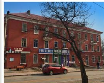
4. 建筑山墙面及窗洞口1
