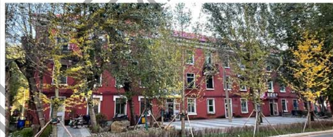
2. 建筑沿街立面及门窗洞口
