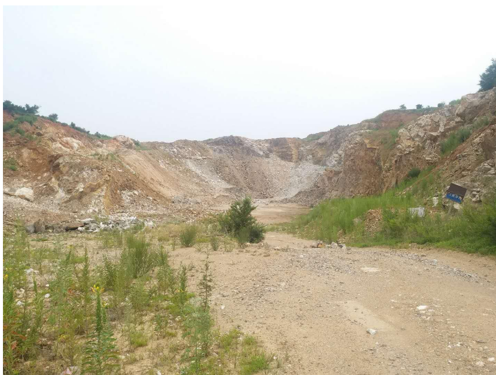
图 3-3 已建露天采场 2 挖损损毁土地现状照片
