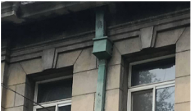
7. 窗洞口顶部线脚
