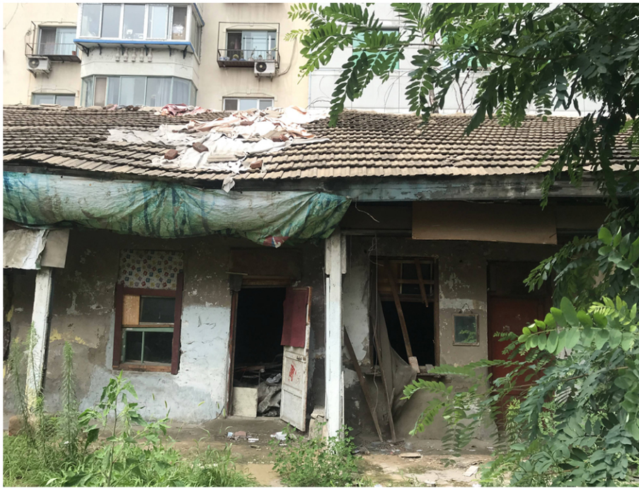
4. 南立面及窗门洞口
