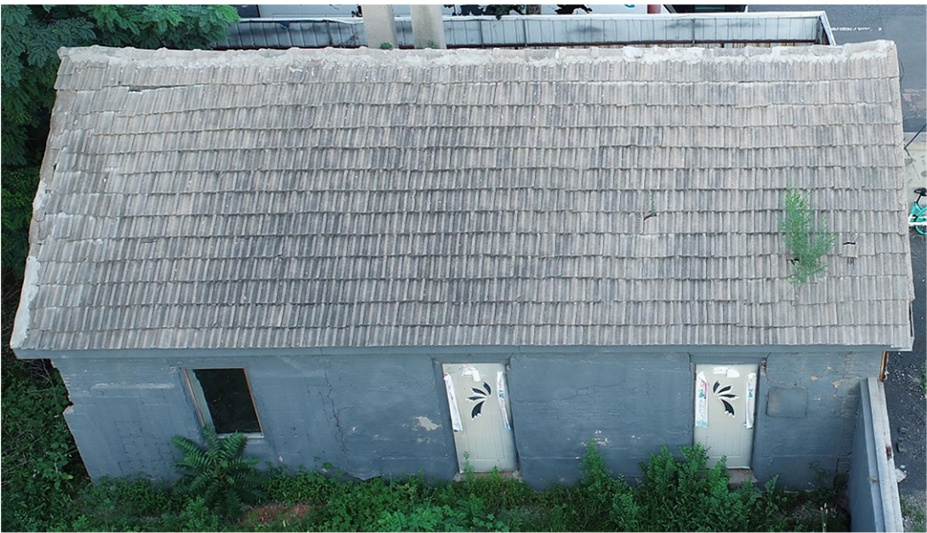
1. 双坡屋顶、檐口及西立面
