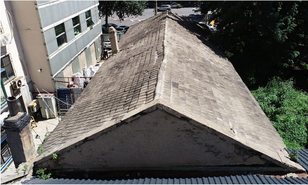
1. 屋顶及西侧山墙
