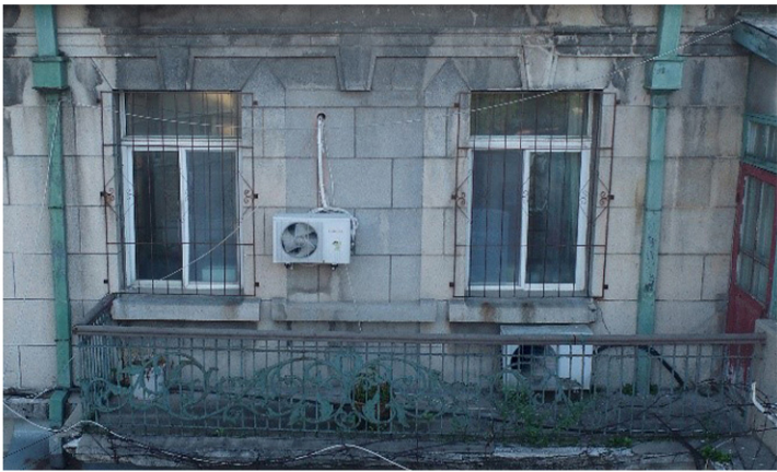
5. 窗洞口及栏杆扶手
