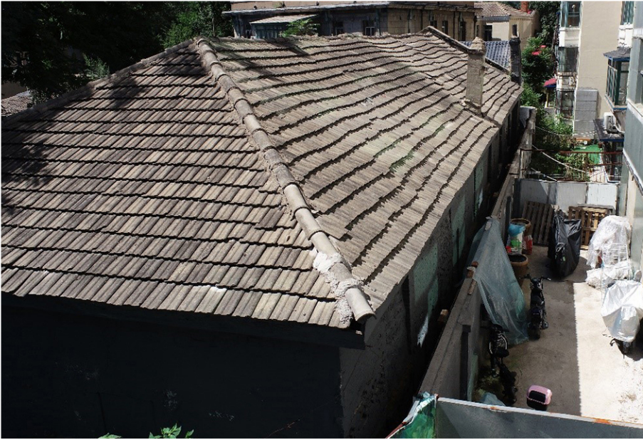
2. 屋顶及北立面
